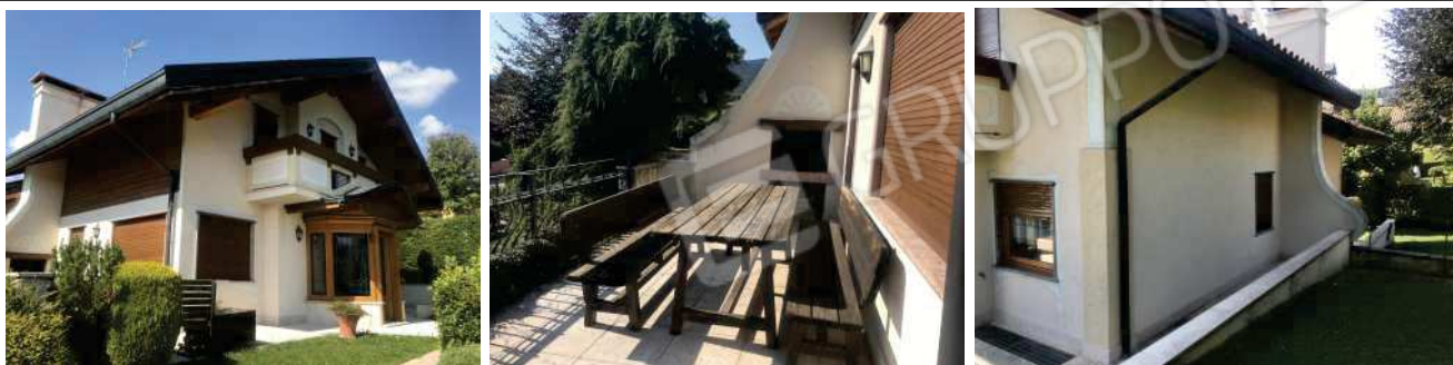
Foto 2-3-4 Prospetti sud-est con area attrezzata e prospetto nord
