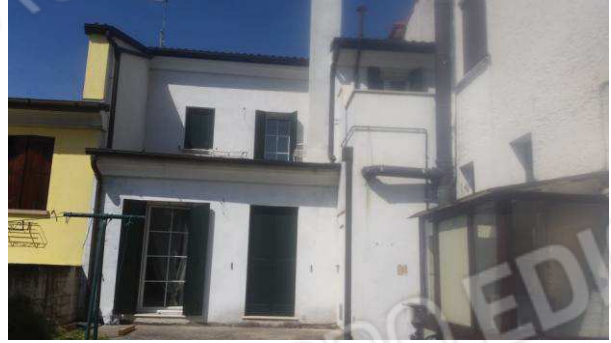
FOTO 2 – LATO SUD/ CORTILETTO SUB 10
