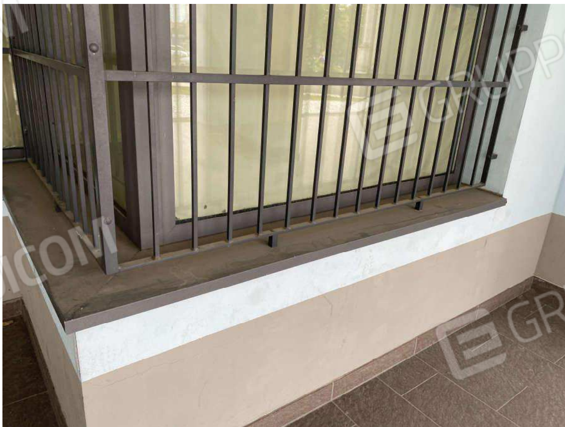
Foto 14 - particolare degli infissi
