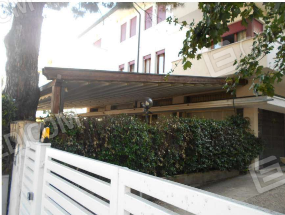
Foto 13: pergolato verso via Vo' de Buffi ad uso della pizzeria
