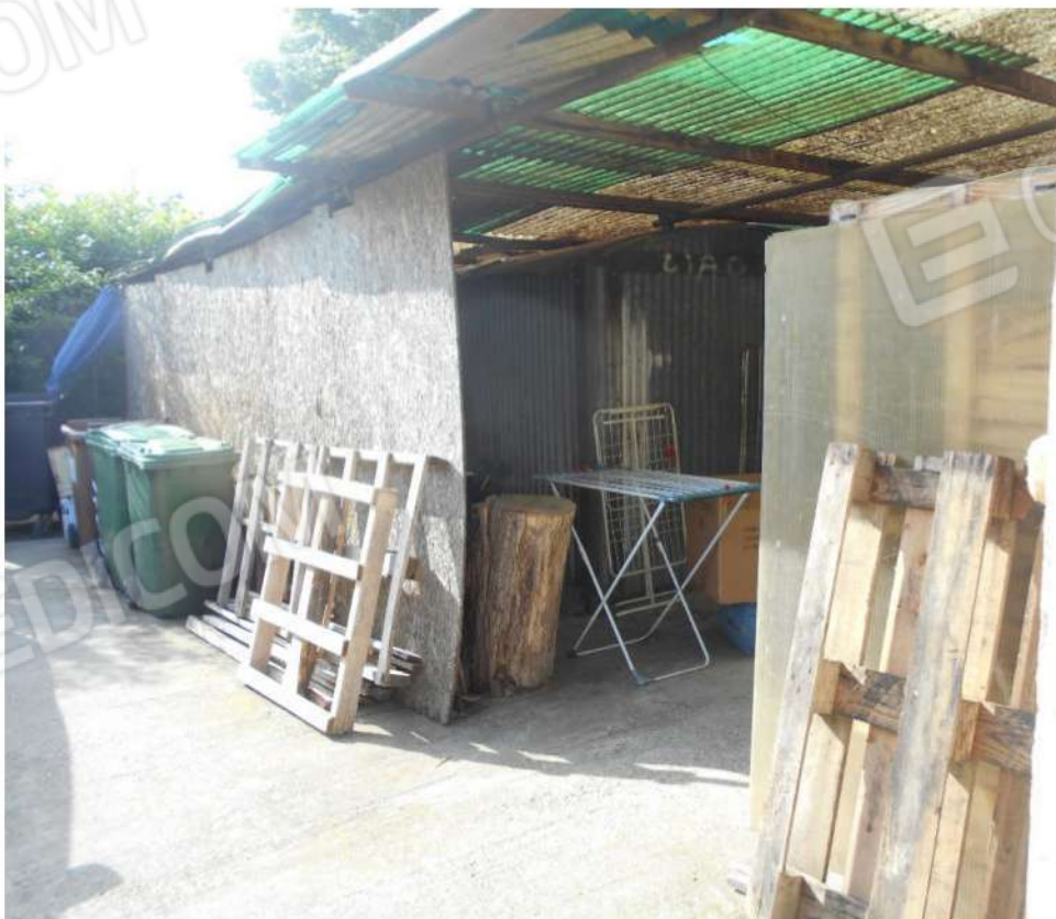
Foto 5: zona magazzino utilizzata dalla pizzeria
