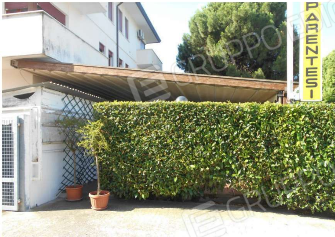
Foto 12: pergolato verso via Vo' de Buffi ad uso della pizzeria
