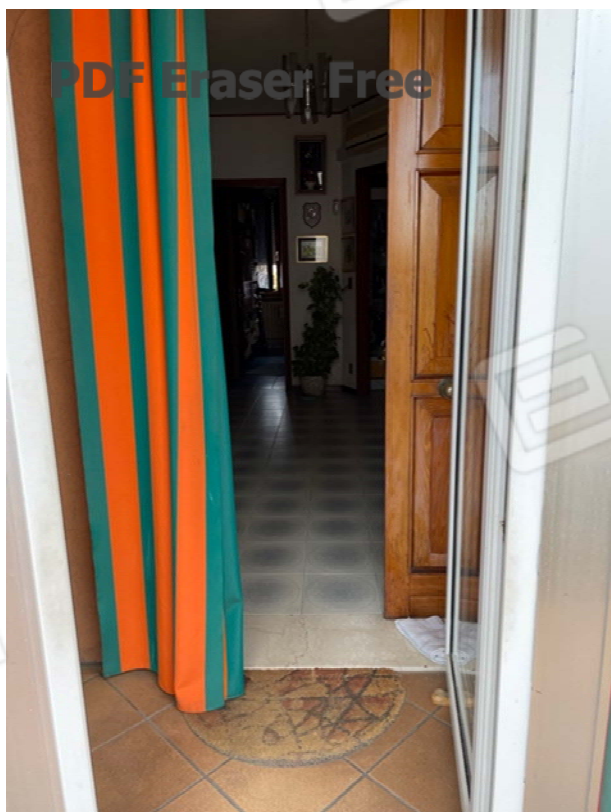
Viste dell'ingresso all'appartamento
