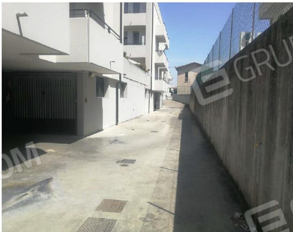
Fotografia n. 12 – Fabbricato lato Est con corridoio di transito per accesso ai garages degli automezzi
