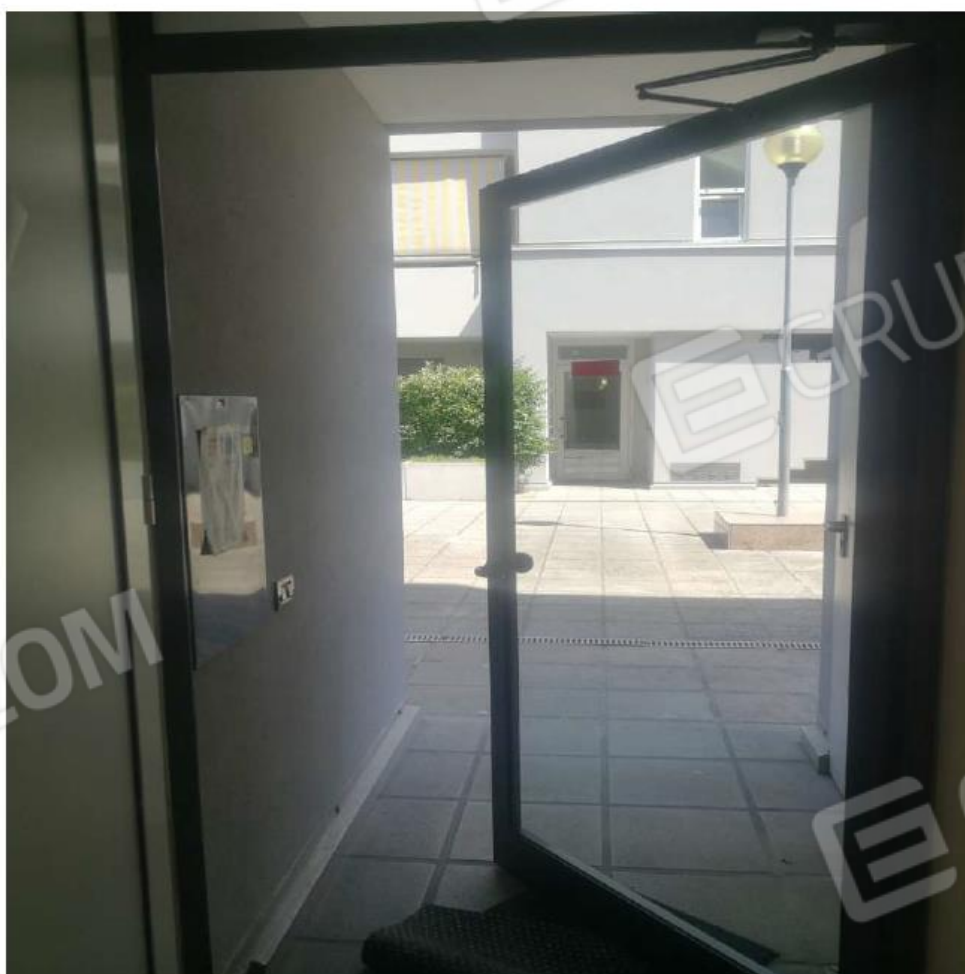
Fotografia n. 14 – Portone d'ingresso del fabbricato
