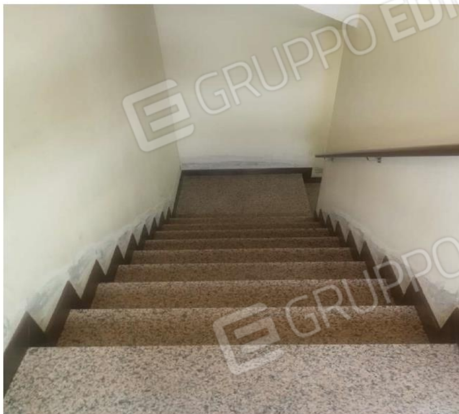
Fotografia n. 39 – Scala di accesso al Piano Interrato
