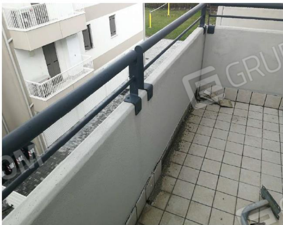
Fotografia n. 32 – Terrazzino con accesso dalla camera matrimoniale (con piastrellature distaccate)
