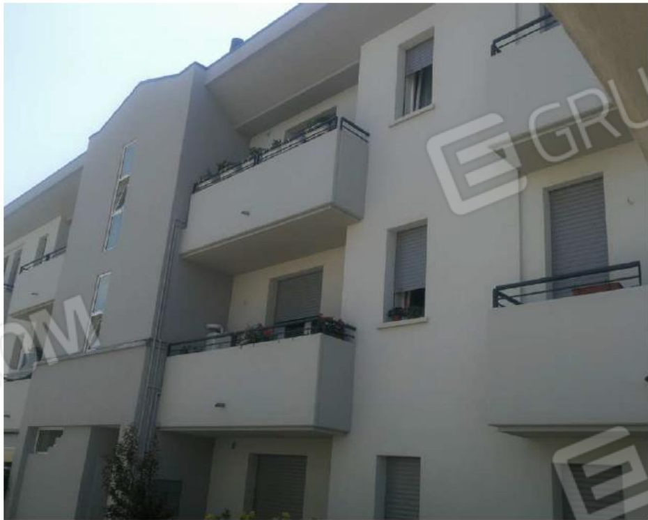
Fotografia n. 10 – Fabbricato facciata Nord
