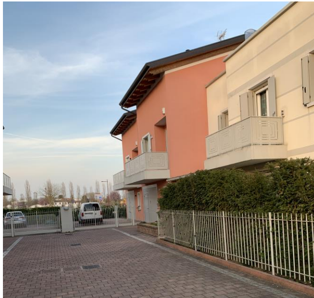
Abitazione trifamiliare in via Nardi n. 4 a Rubano - coordinate Google 45°25'49.1"N 11°46'57.2"E
