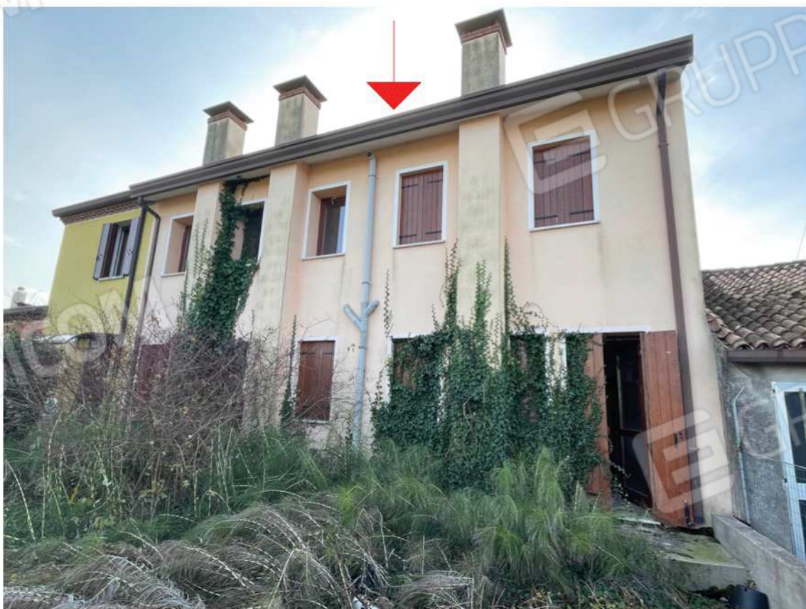
5 - Vista lato nord
