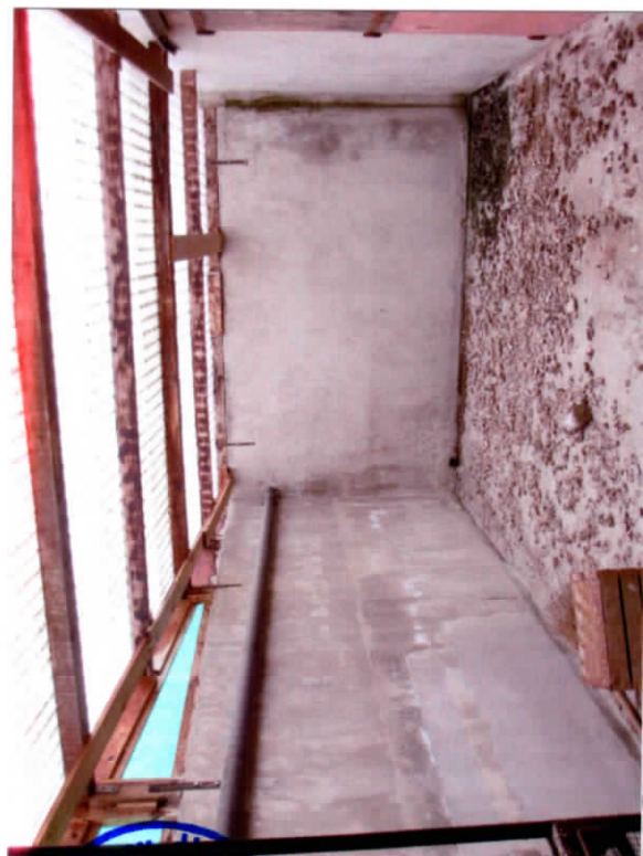
22 – Particolare d'interni: Porz. NordEst Sottotetto LOTTO 19
