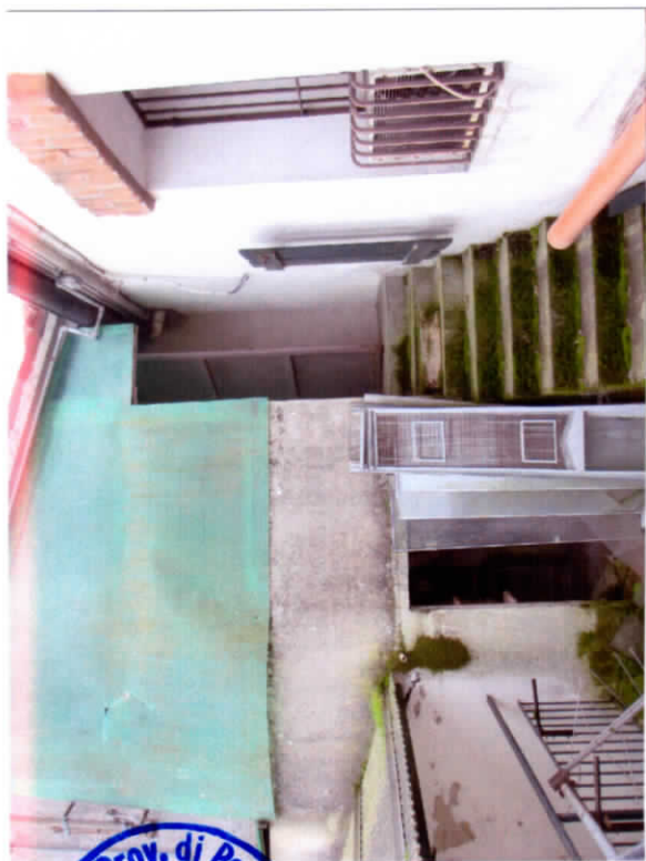
10 – Vista da Terrazza P.1° Zona Est LOTTO 19
