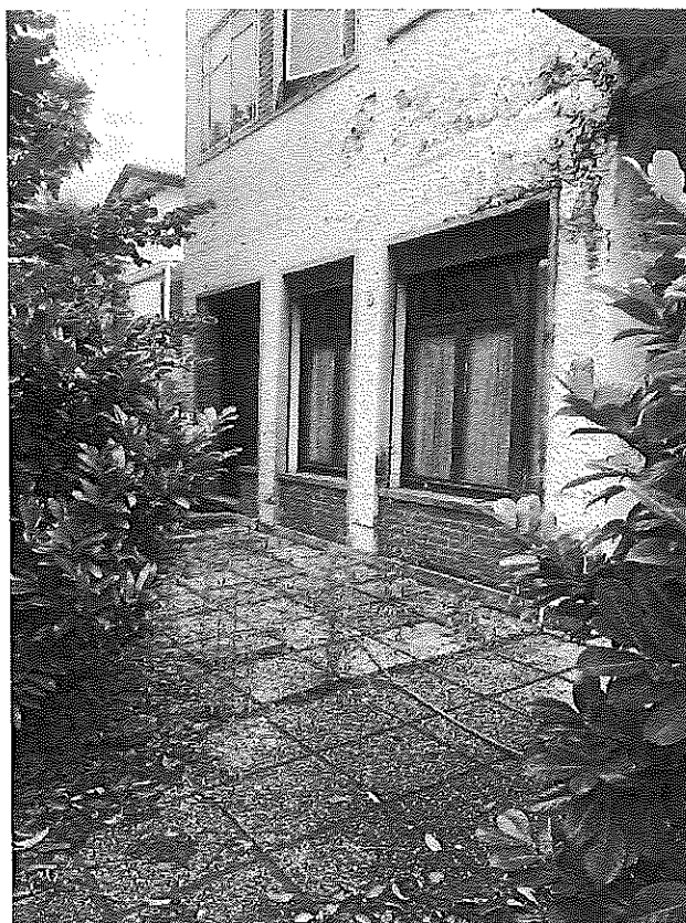
Figura 74 – Particolare facciata sua via Facciolati
