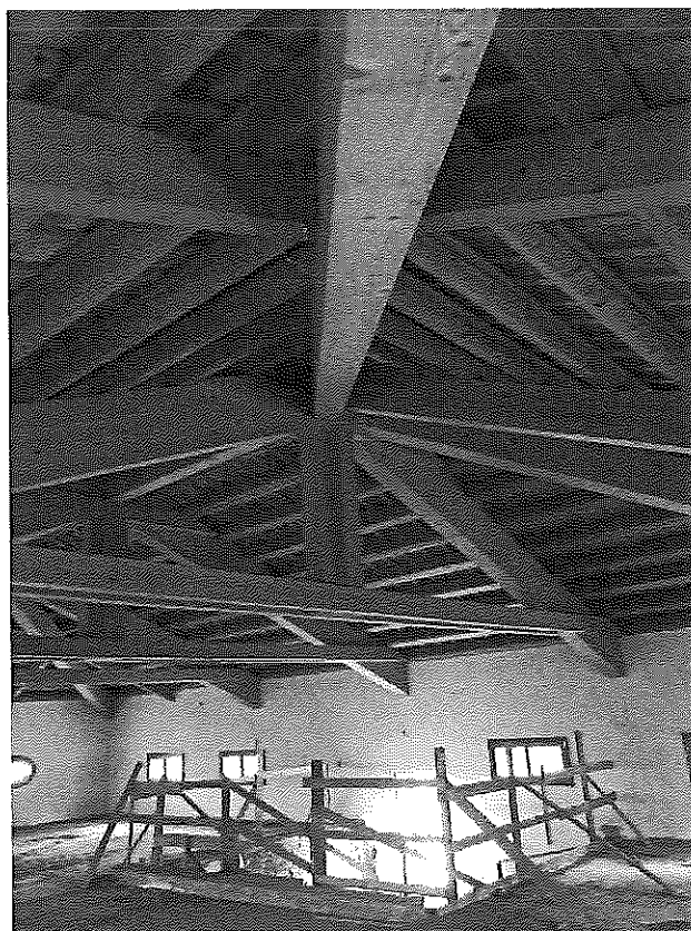
Figura 59 – Sottotetto della villa
