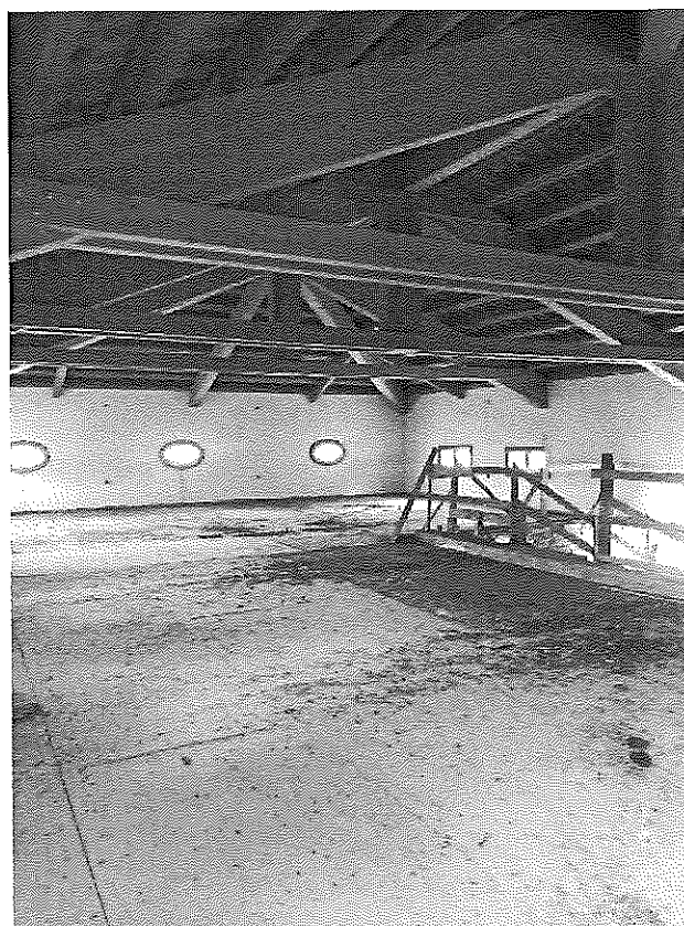
Figura 58 – Sottotetto della villa
