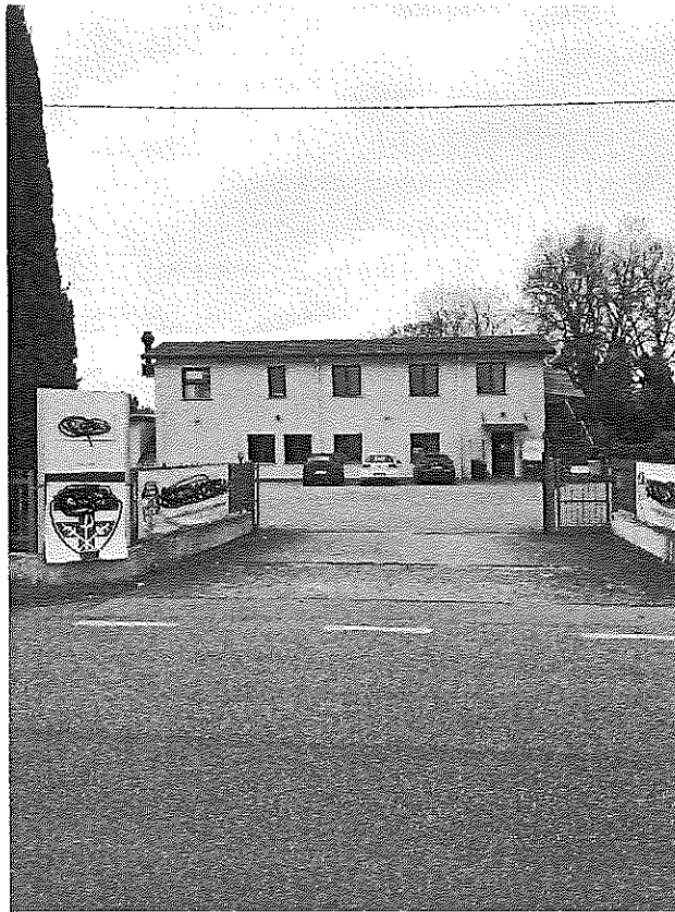
Figura 2 – Accesso al fabbricato
