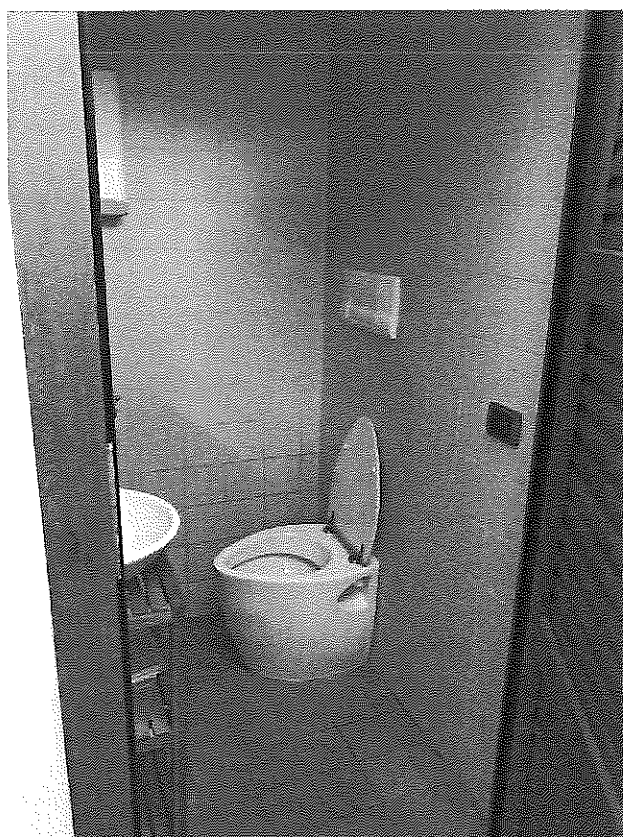
Figura 19 – Locale w.c. (spogliatoio maschile)
