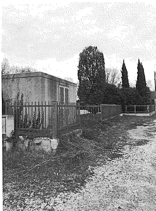
Figura 37 – Recinzione su via Frassanedo e cabina elettrica
