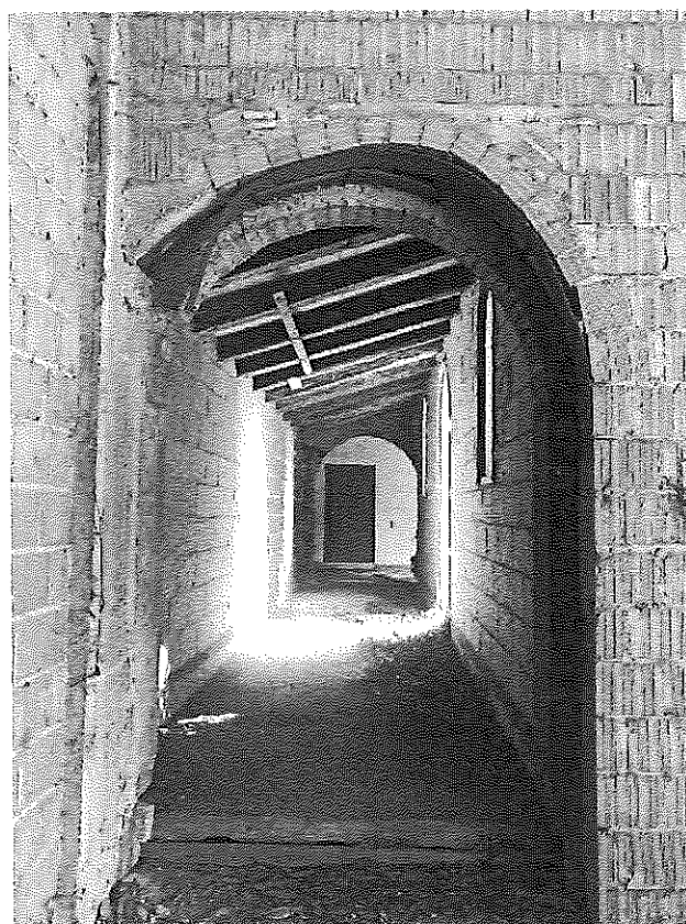
Figura 63 – Collegamento tra edificio 1 edificio 4
