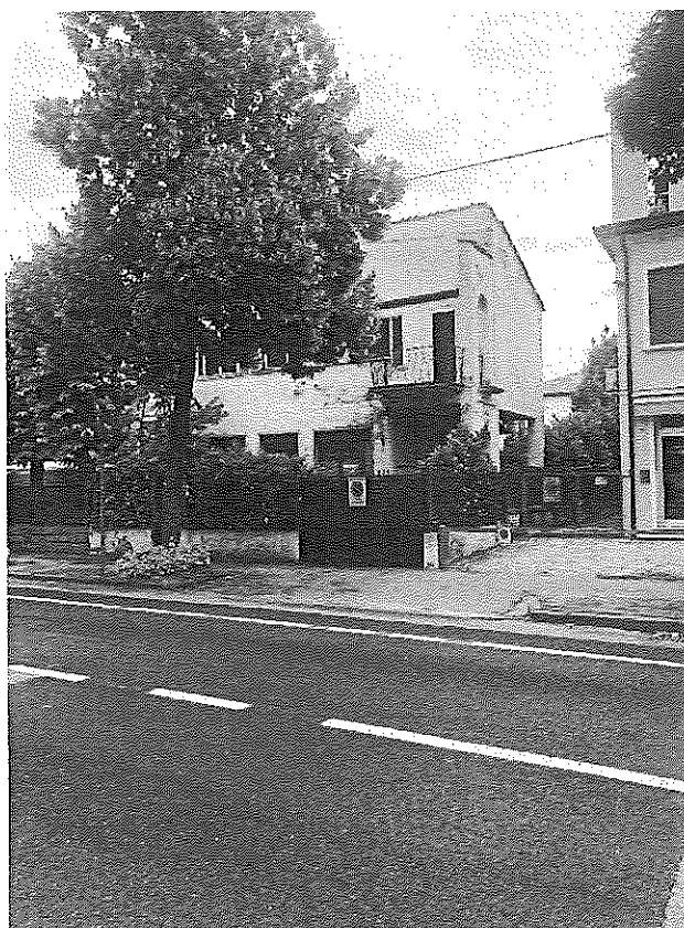
Figura 73 – Angolo sud del fabbricato
