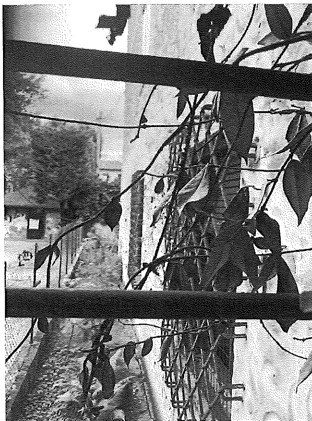
Figura 87 – Cortile sul lato nord-ovest
