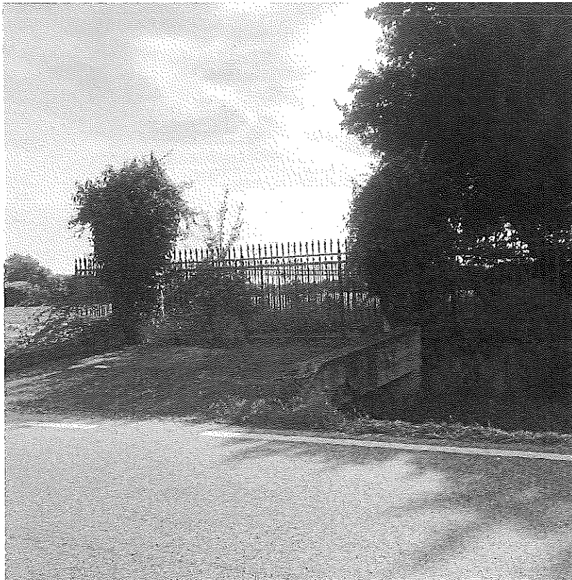
Figura 67 – Accesso da via Frassanedo al mappale 210
