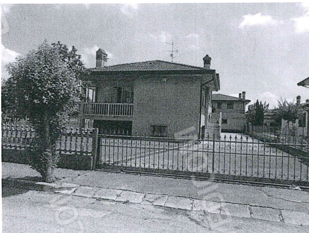
Foto 8: prospetto ovest, da via De Gasperi
