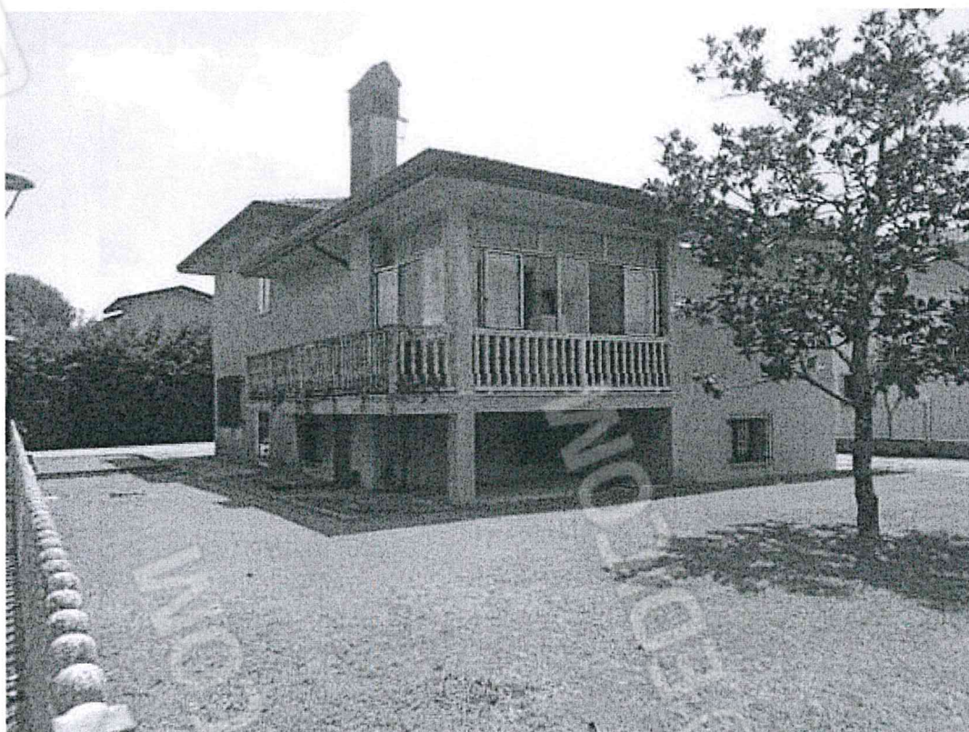
Foto 6: prospetti nord ed ovest dell'abitazione, cortile pertinenziale
