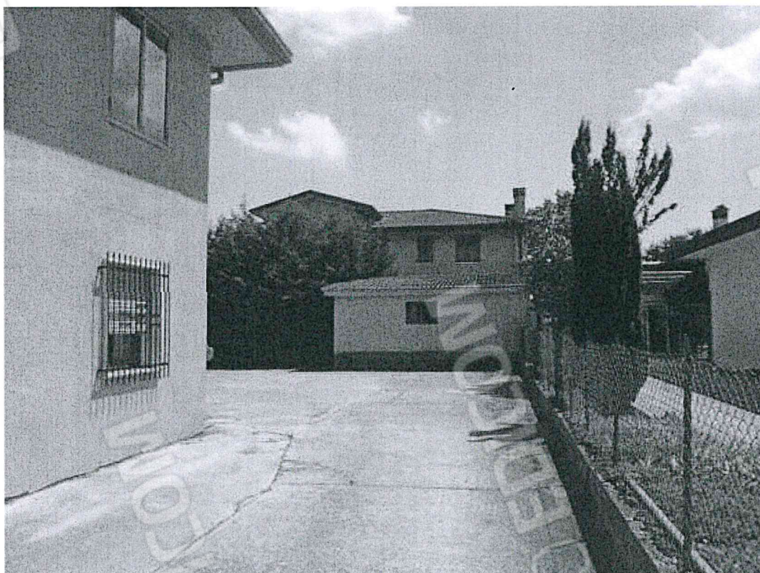
Foto 14: corpo di fabbrica a garage
