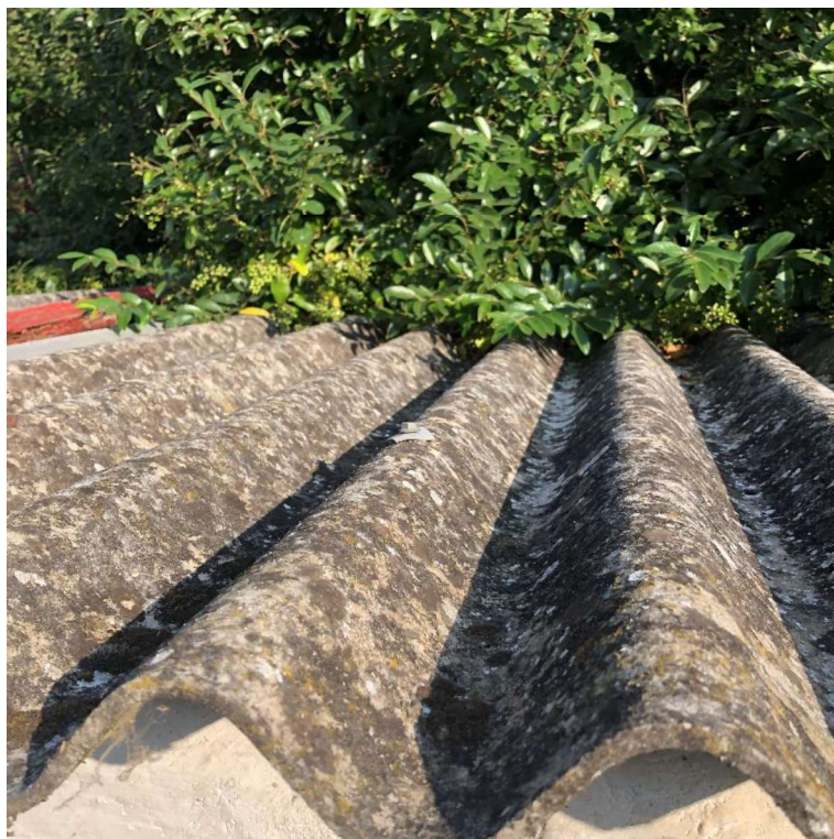
Figura 12 – Copertura in eternit del ricovero attrezzi
