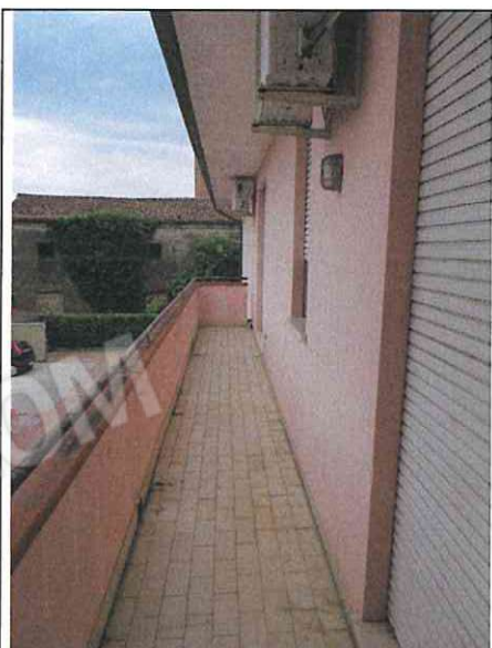
Foto n°17: Balcone su fronte est
