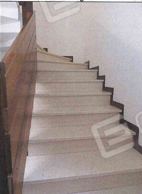
Foto n°14: Scala di accesso
