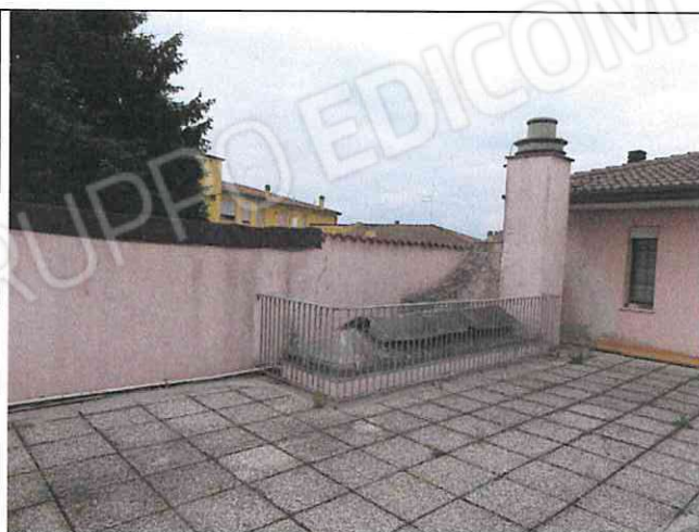
Foto n°58: altra vista ampio terrazzo verso nord (non di proprietà)
