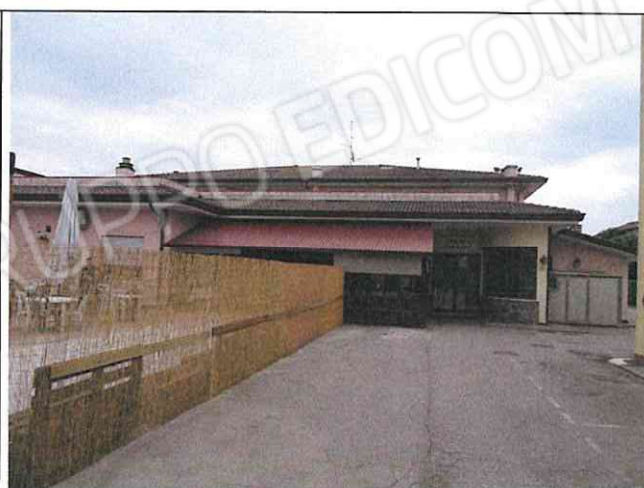
Foto n°4: Ingresso carraio da strada comunale
