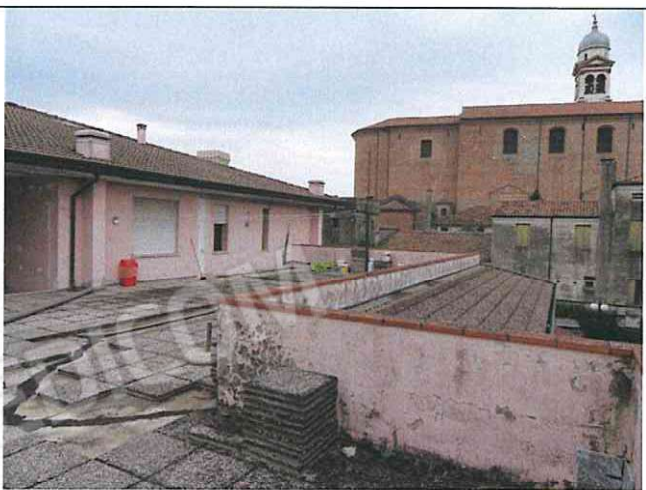
Foto n°61: altra vista ampio terrazzo verso sud est
