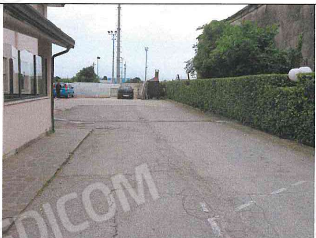
Foto n°7: Accesso carraio al retro dell'immobile
