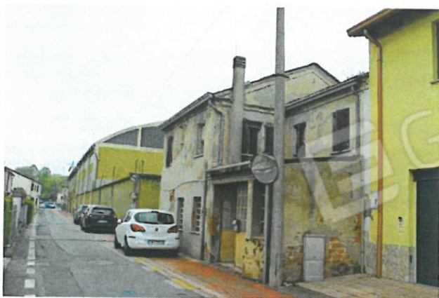
1 – Prospetto principale su via Matteotti
