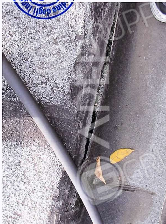
7 – Crepa d'angolo tipo della guaina impermeab. P.1°
