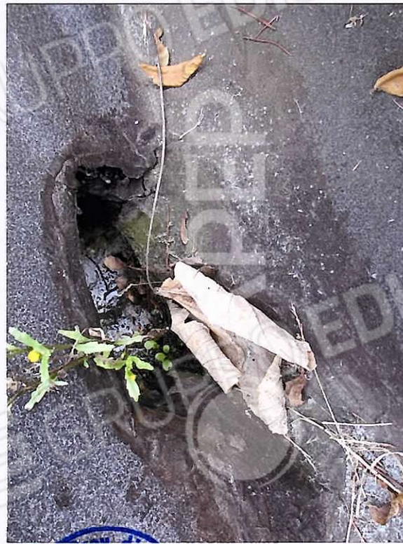
8 – Distacco-crepe tipo della guaina su bocchetta di scarico P.1°
