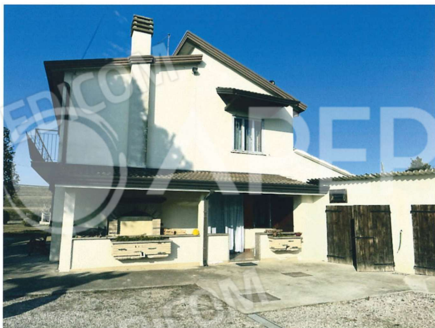
Fabbricato vista Est
