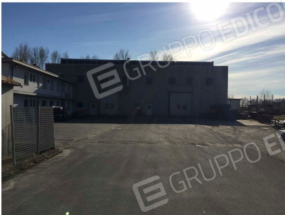
6 - Vista lato nord officina
