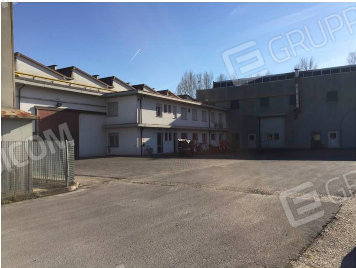
5 - Vista lati nord/ovest
