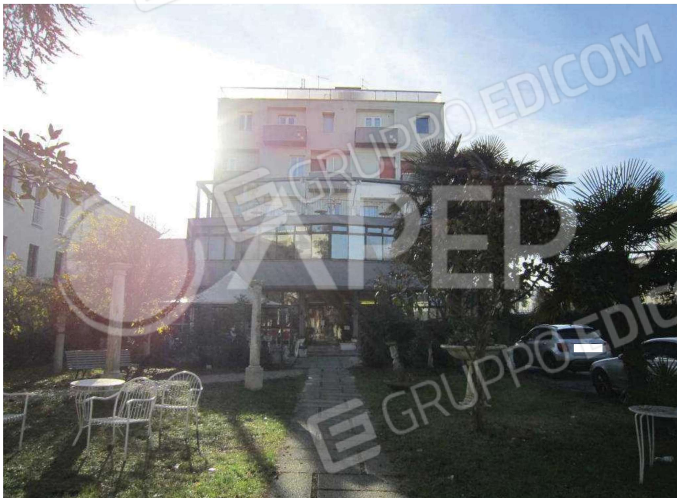
Veduta dell'ingresso pedonale verso l'hotel
