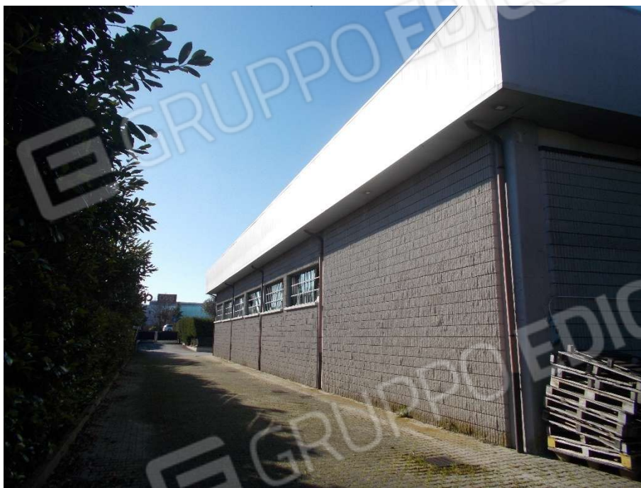
Foto 3- LOTTO 1- Vista lato est
