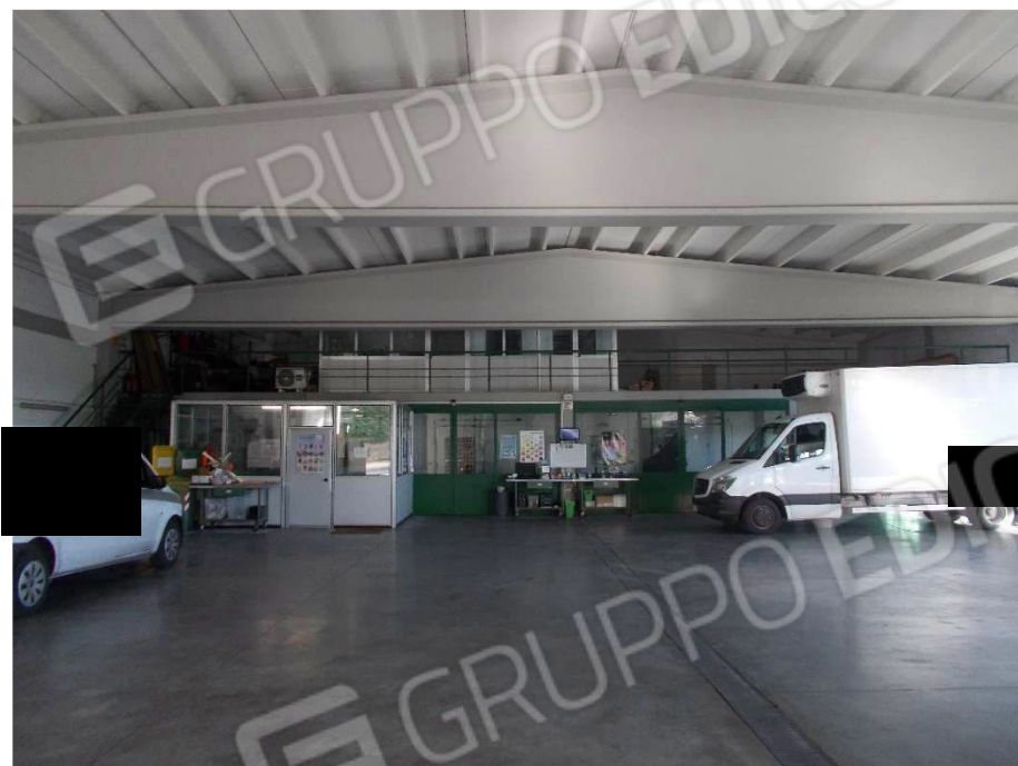
Foto 5- LOTTO 1- Magazzino -sub. 5
