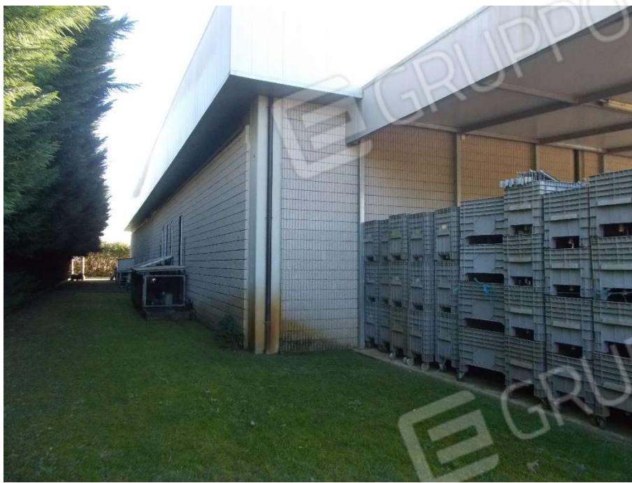
Foto 4- LOTTO 1- Vista lato nord
