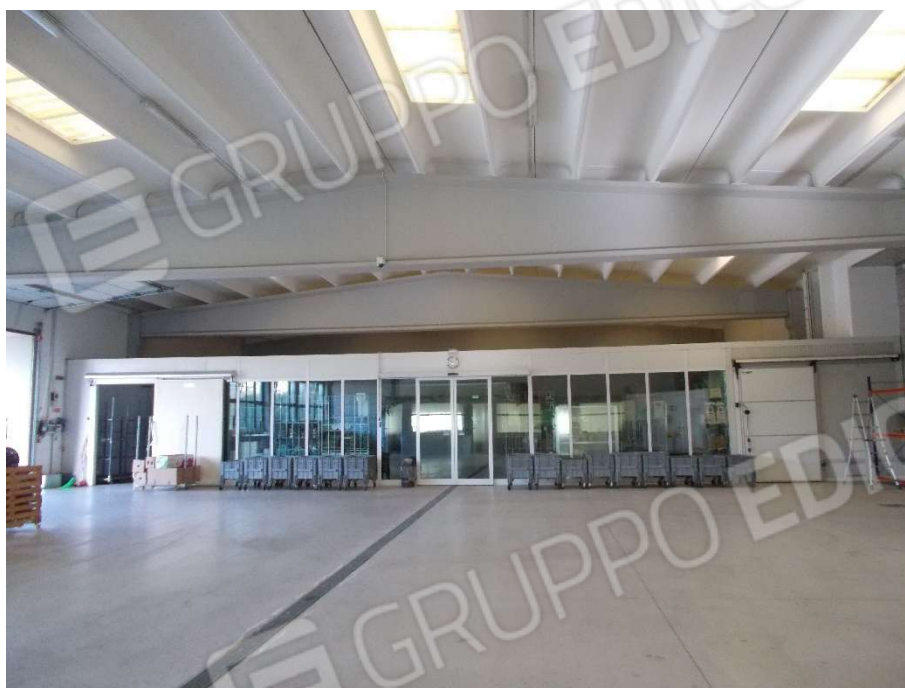
Foto 9- LOTTO 1- Reparto celle frigorifere - sub. 5
