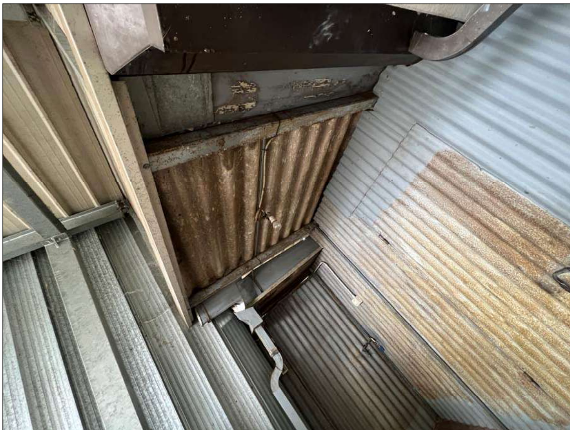
Cemento amianto in copertura in prossimità dell'accesso alla cantina "C" (sulla destra) Vista dell'accesso al magazzino "E"
