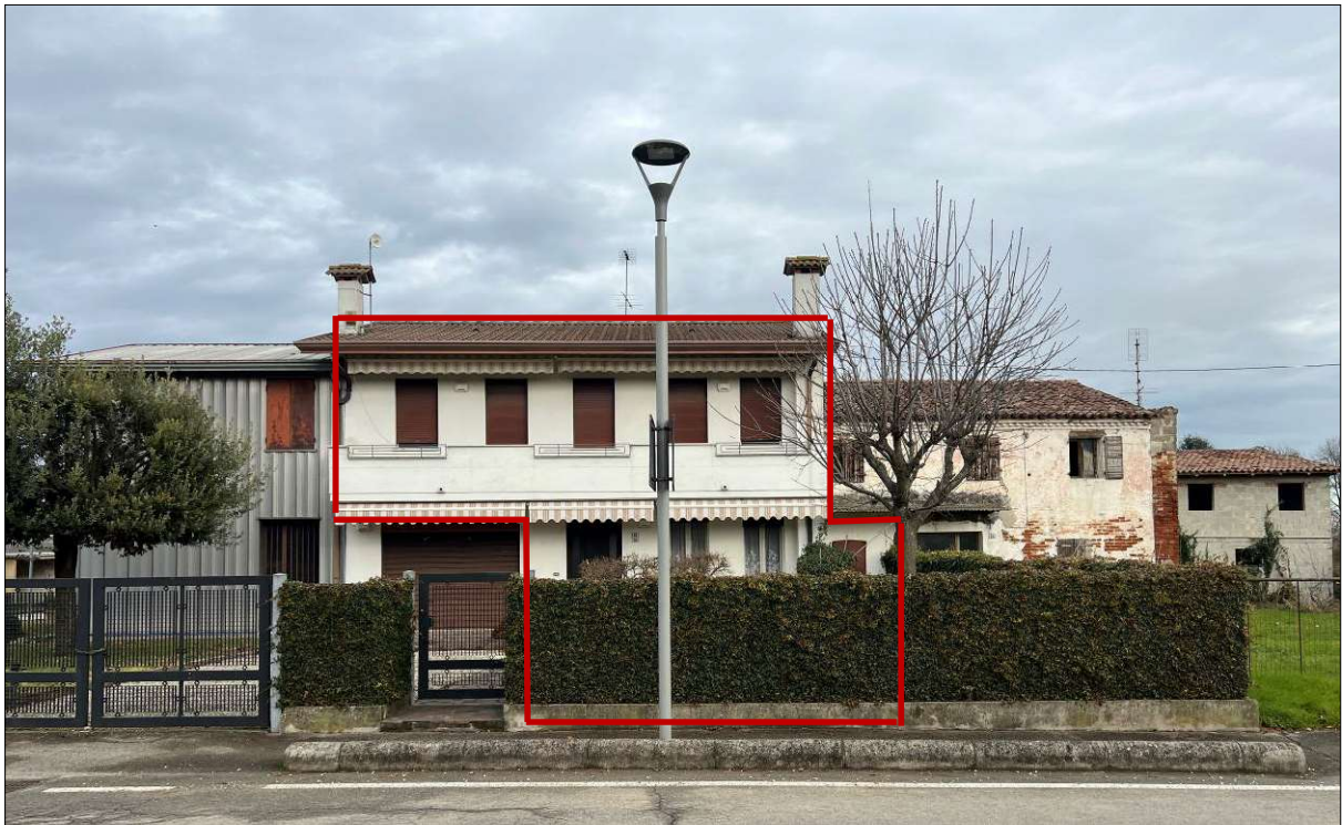
Vista del fabbricato da Sud In rosso inquadramento dell'immobile in oggetto
