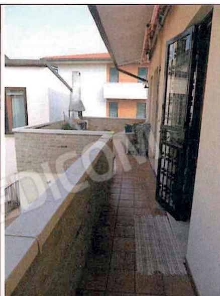
Foto n°8: Poggiolo di accesso all'immobile ed alla terrazza
