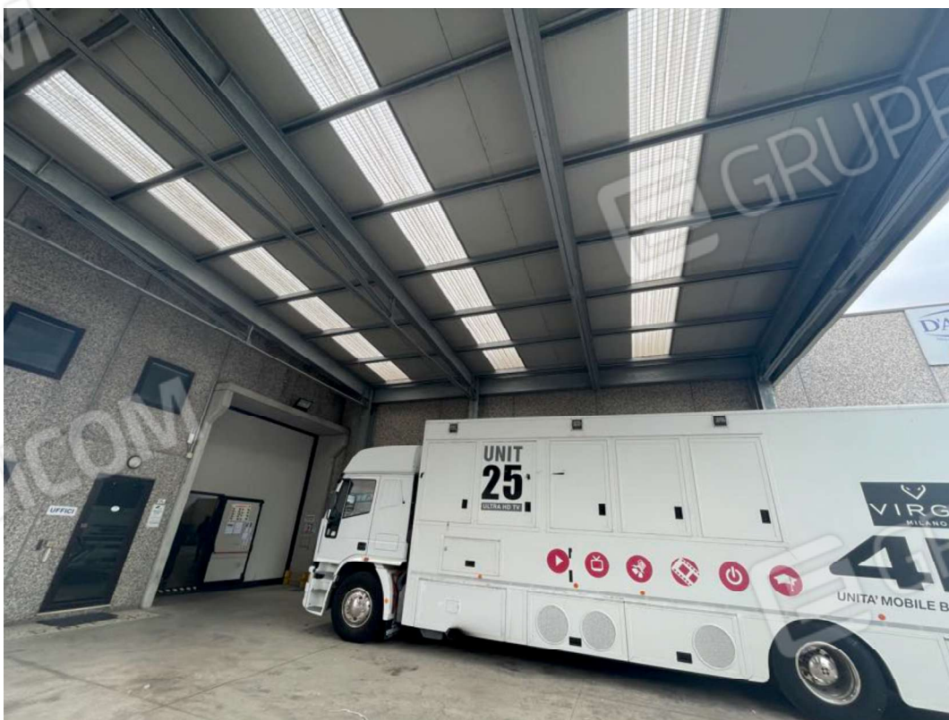
5 - Tettoia zona ingresso
