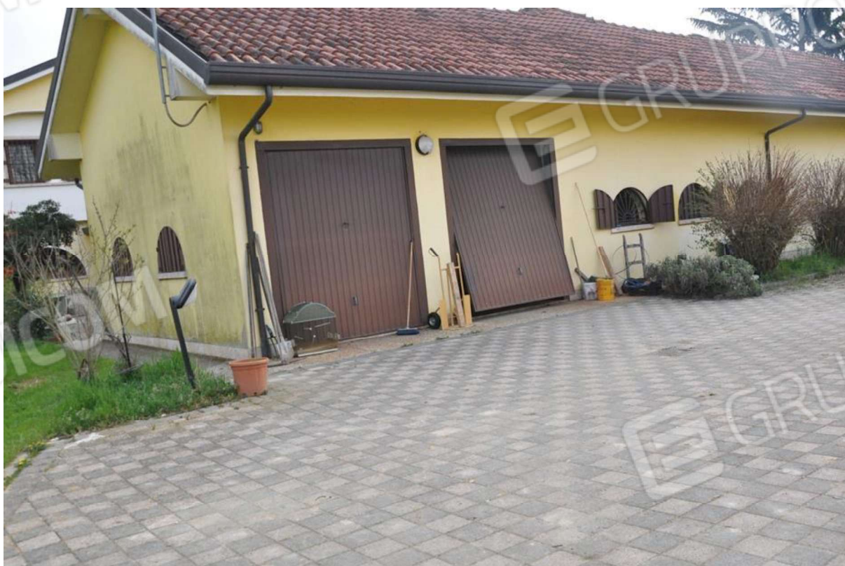
15. Lato ovest - Annessi rustici e garage.
