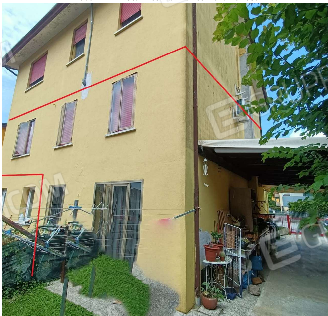
Foto n. 2: Vista interna fronte nord- ovest
