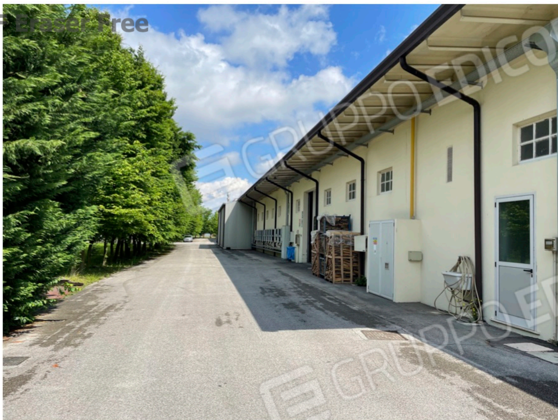
6 - Vista lato ovest
