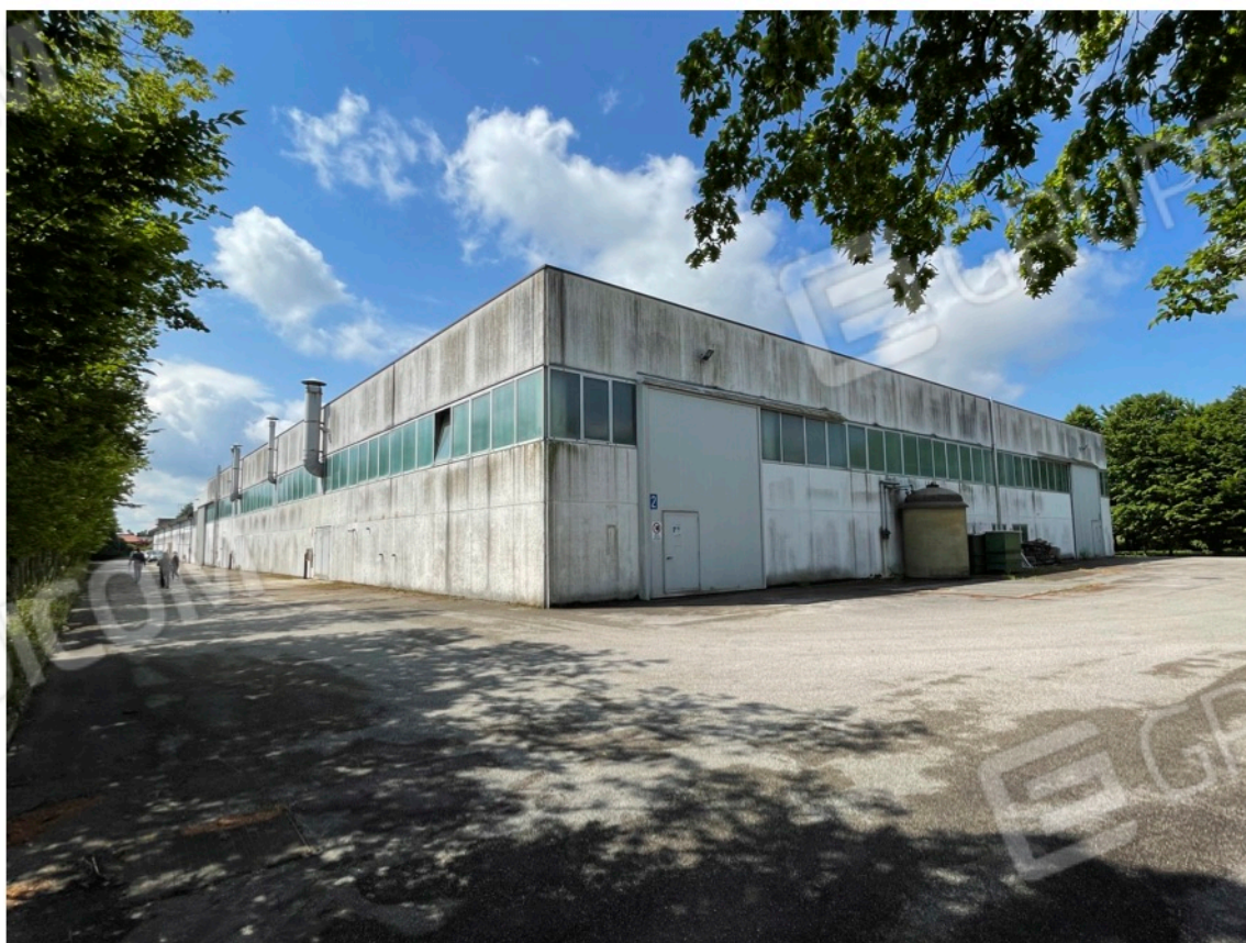
5 - Vista lati nord/est
