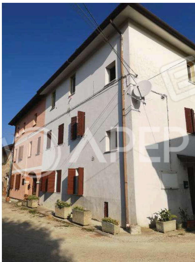
Part. 207 sub. 6 - vista sud-est
