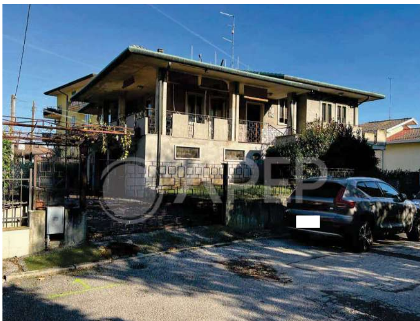
Ripresa prospetto sud ovest
