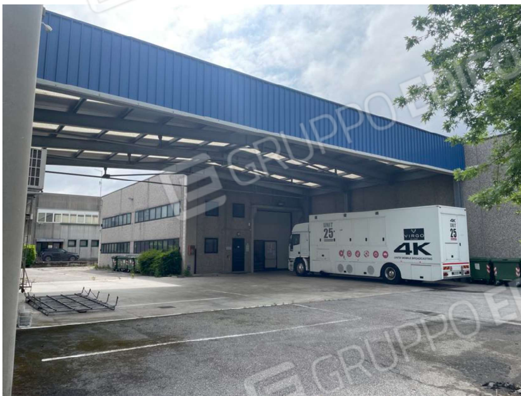
4 - Vista lati nord/ovest
