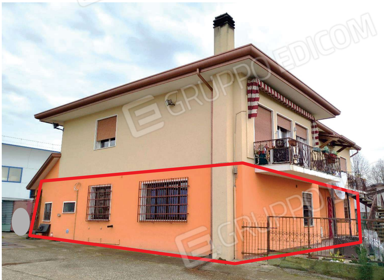
Veduta esterna del complesso bifamiliare
