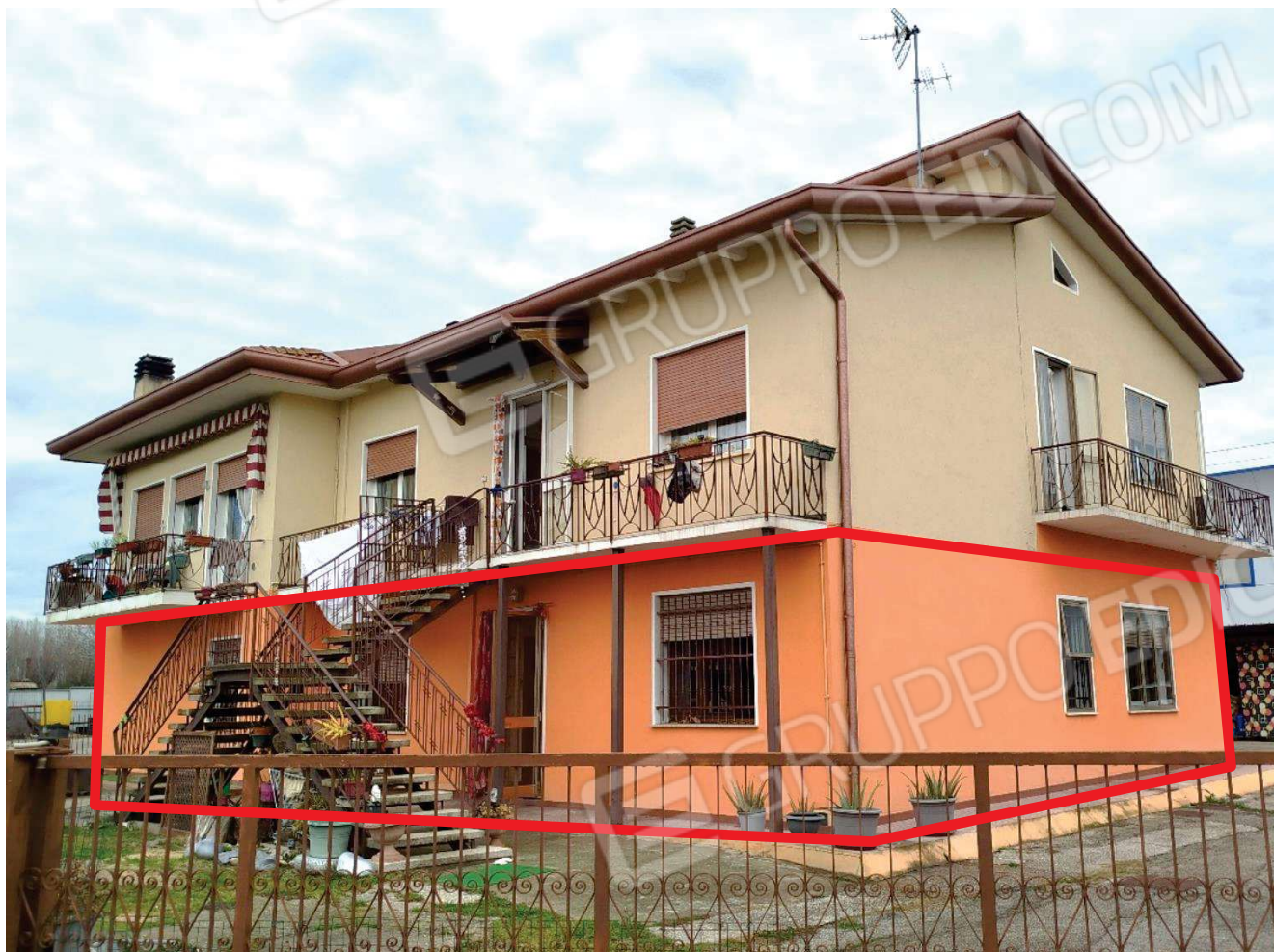
Veduta esterna del complesso bifamiliare
