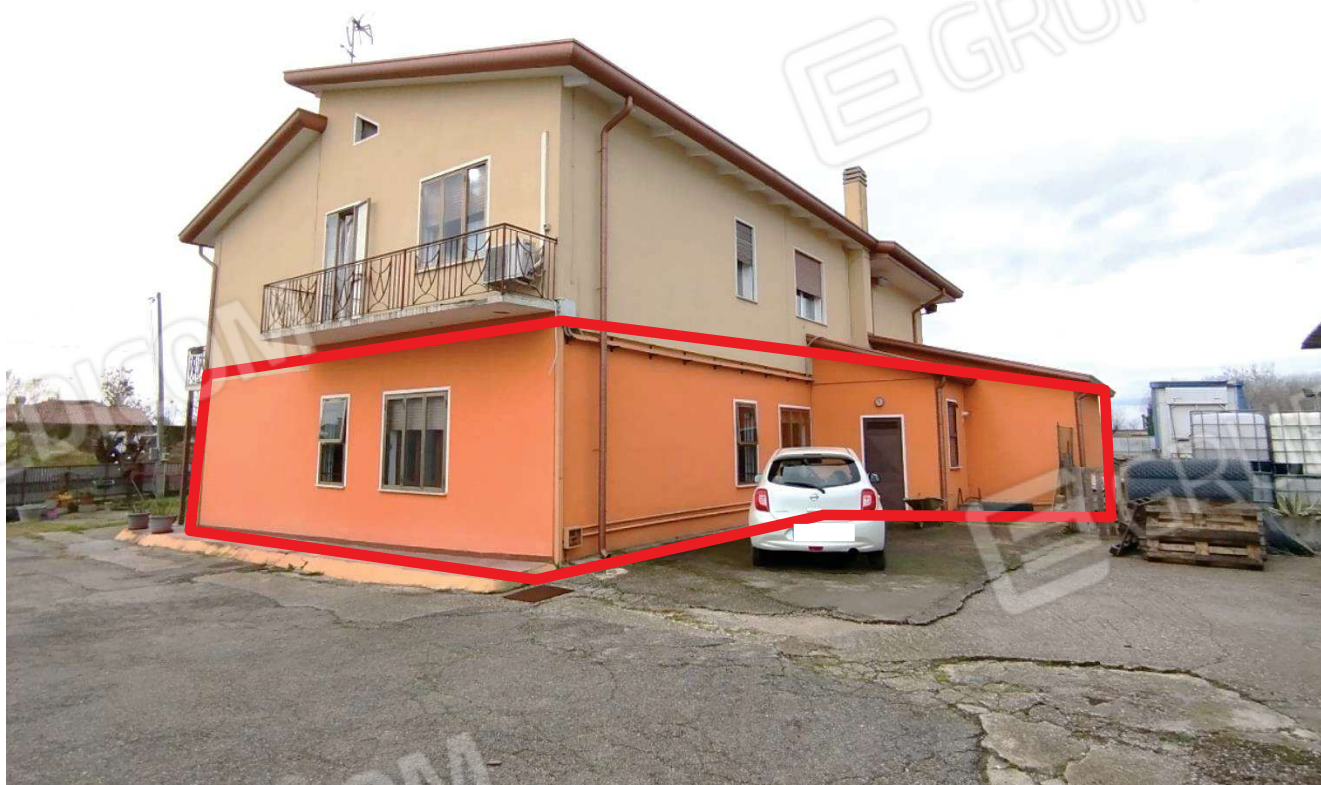
Veduta esterna del complesso bifamiliare
