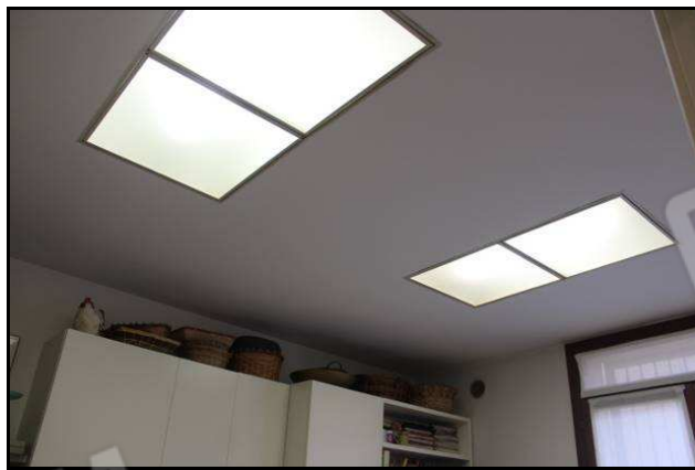
27.- Controsoffitto cucina con plafoniere
