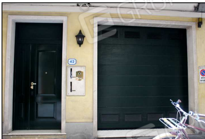
5.- Portone pedonale e carraio del garage pignorato
