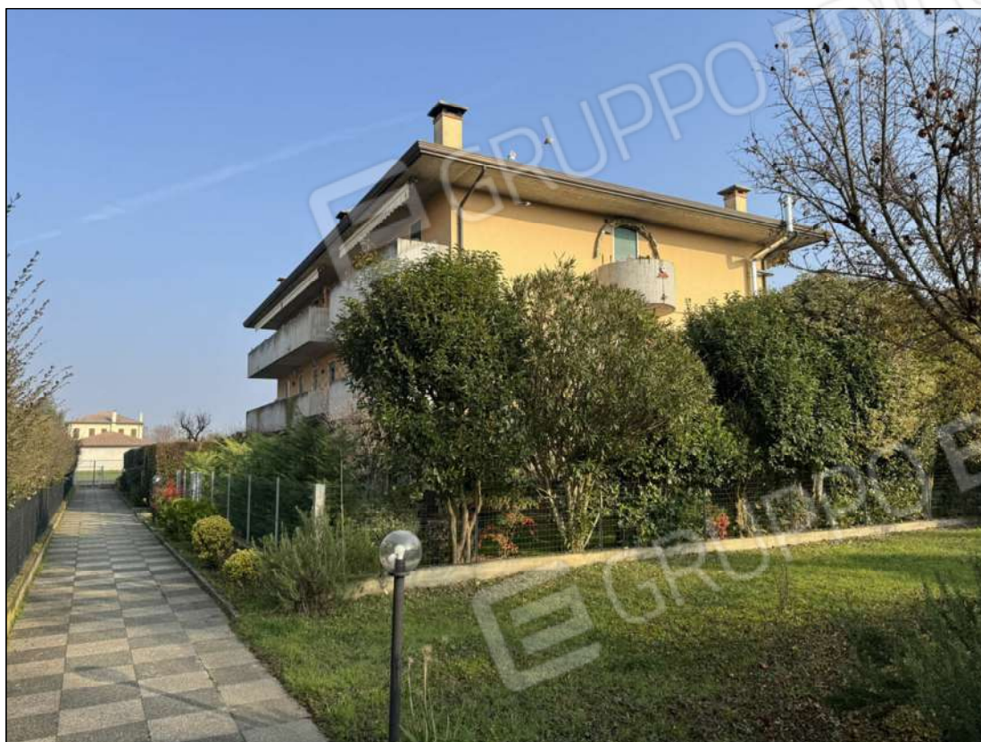
1 - Vista del condominio
