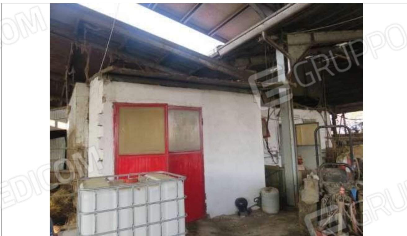
88 Vista dell'ingresso alla sala macchine;
