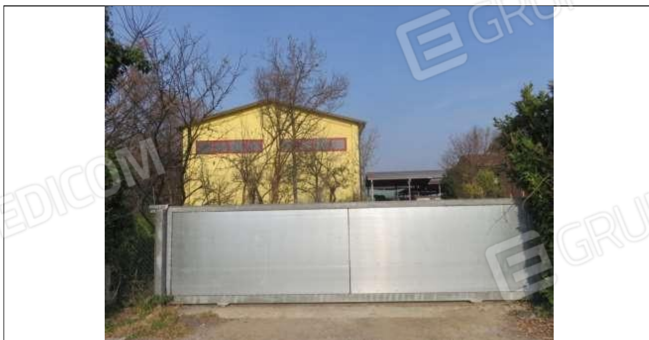
02 Vista del primo accesso carraio;
