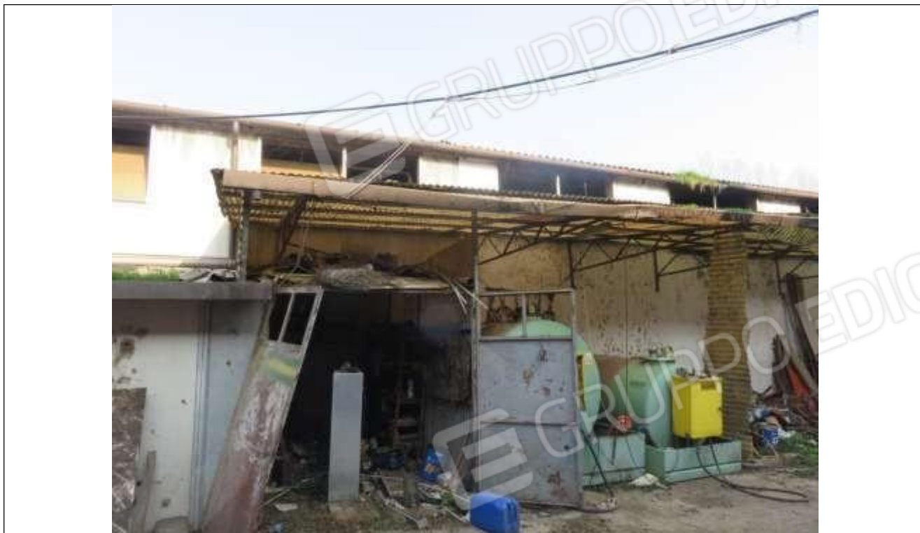
65 Altra vista delle baracche oggetto di rimozione;
