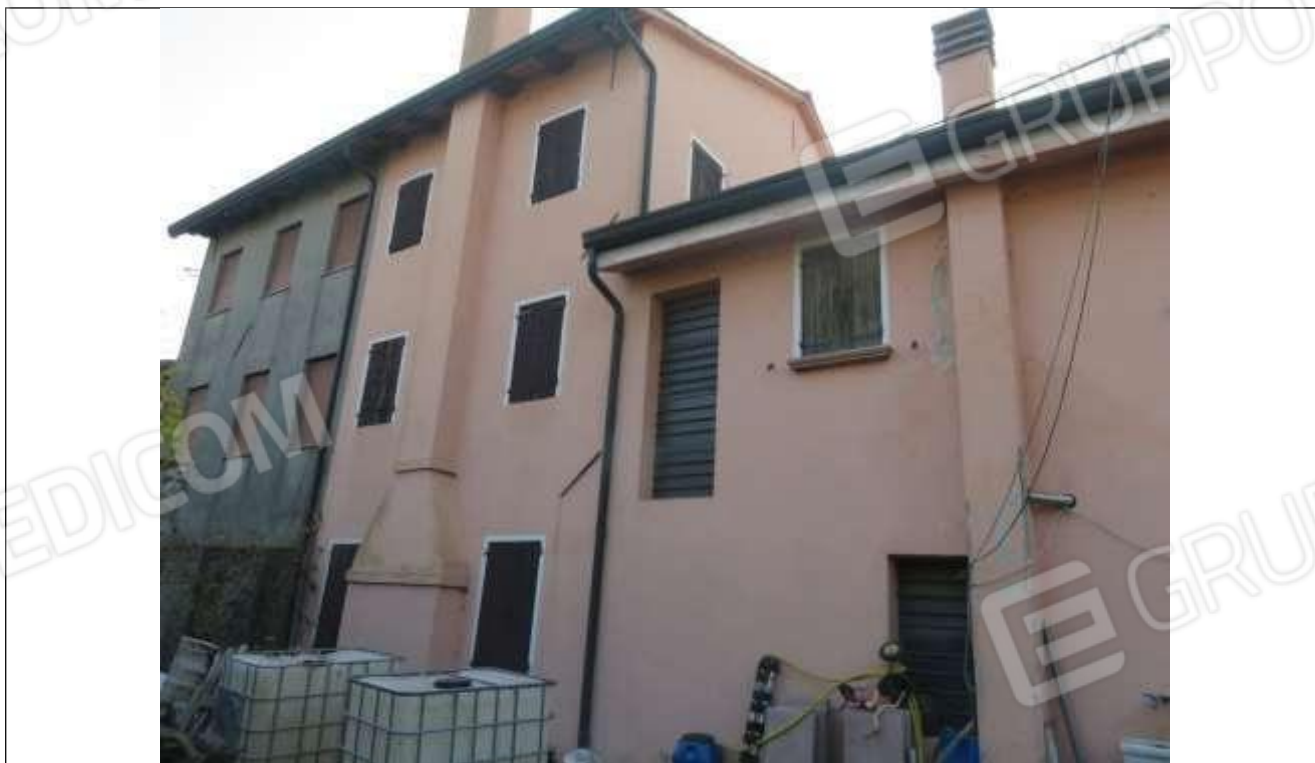
66 Vista del fronte Nord dell'immobile 1 -abitazione;
