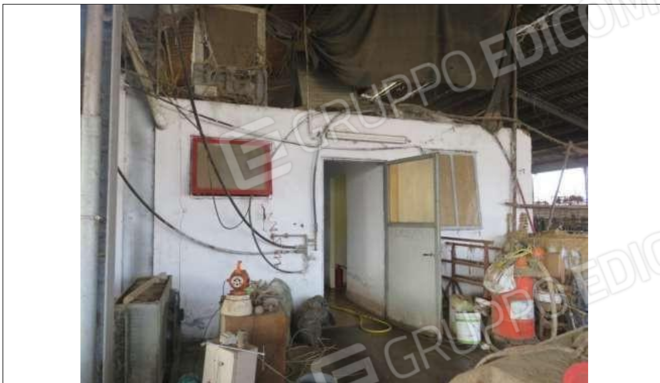
89 Vista dell'ingresso agli uffici;
