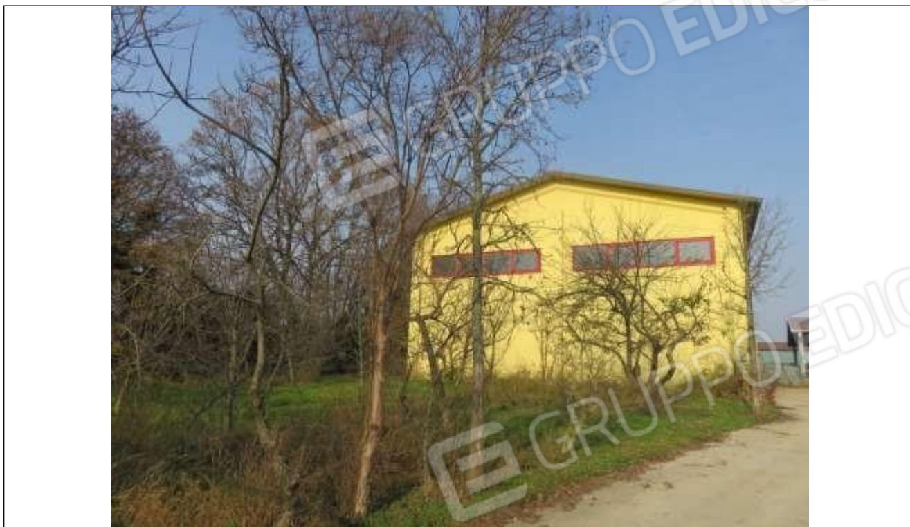
03 Vista interna dell'area scoperta comune, angolo sud-ovest;
