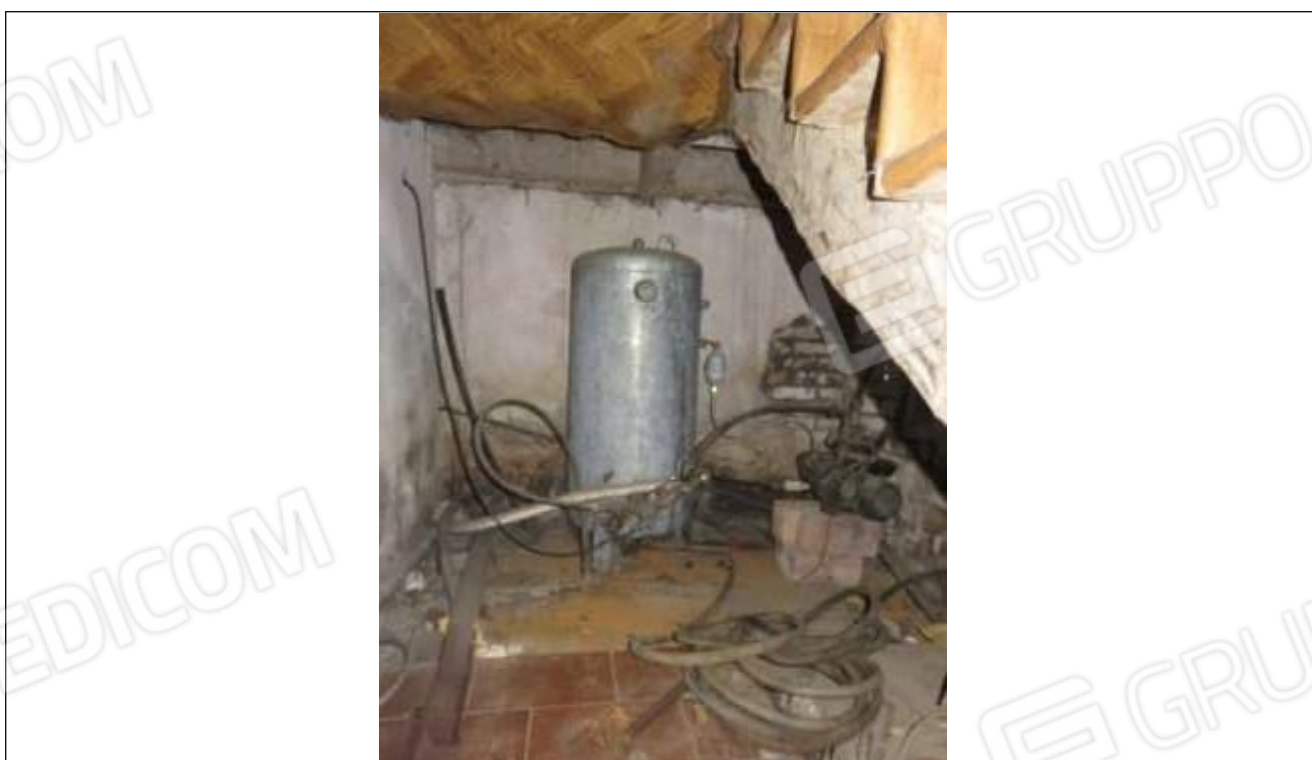
24 Vista del sottoscala;
