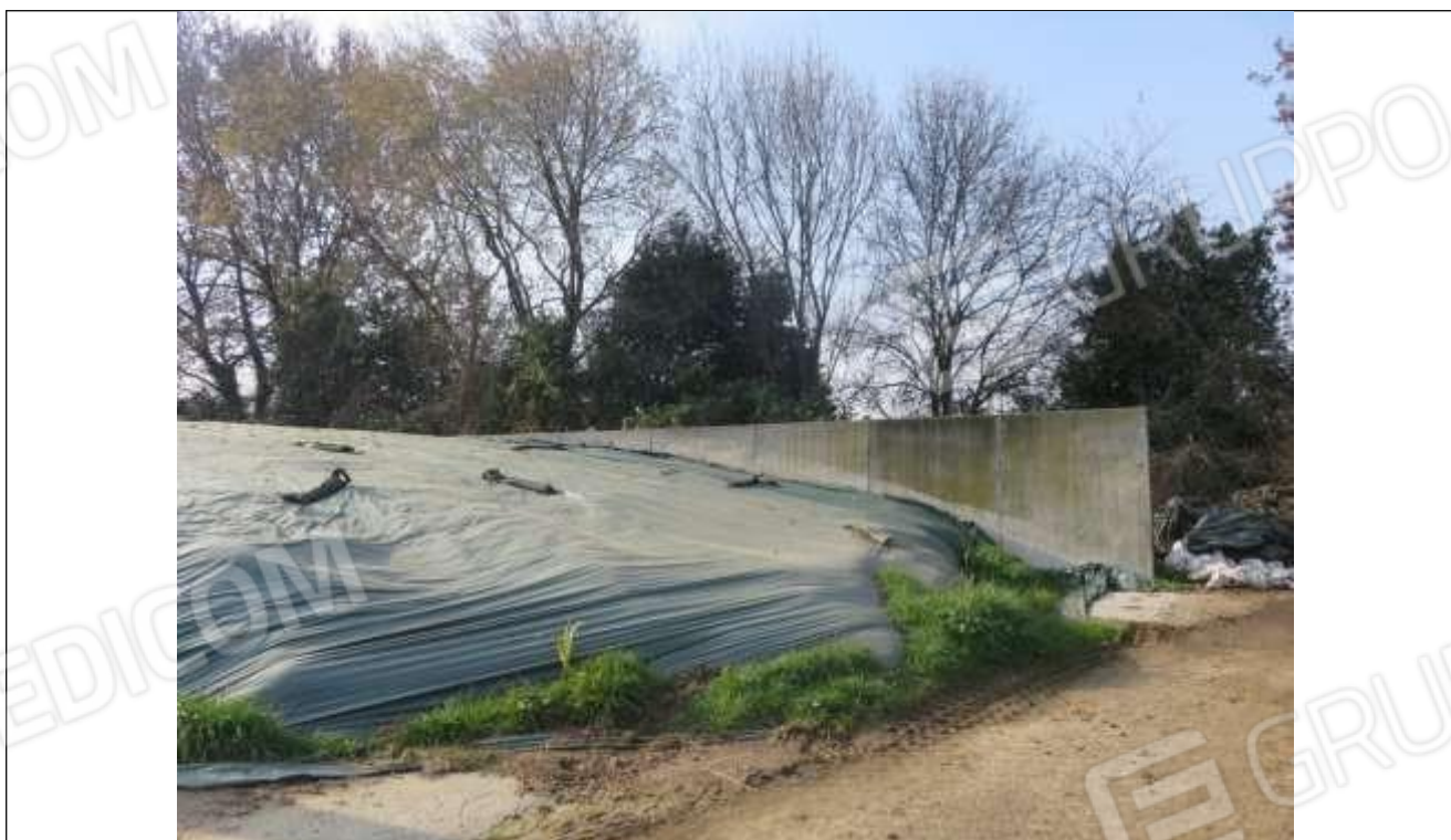
80 Altra vista della concimaia oggetto di demolizione;
