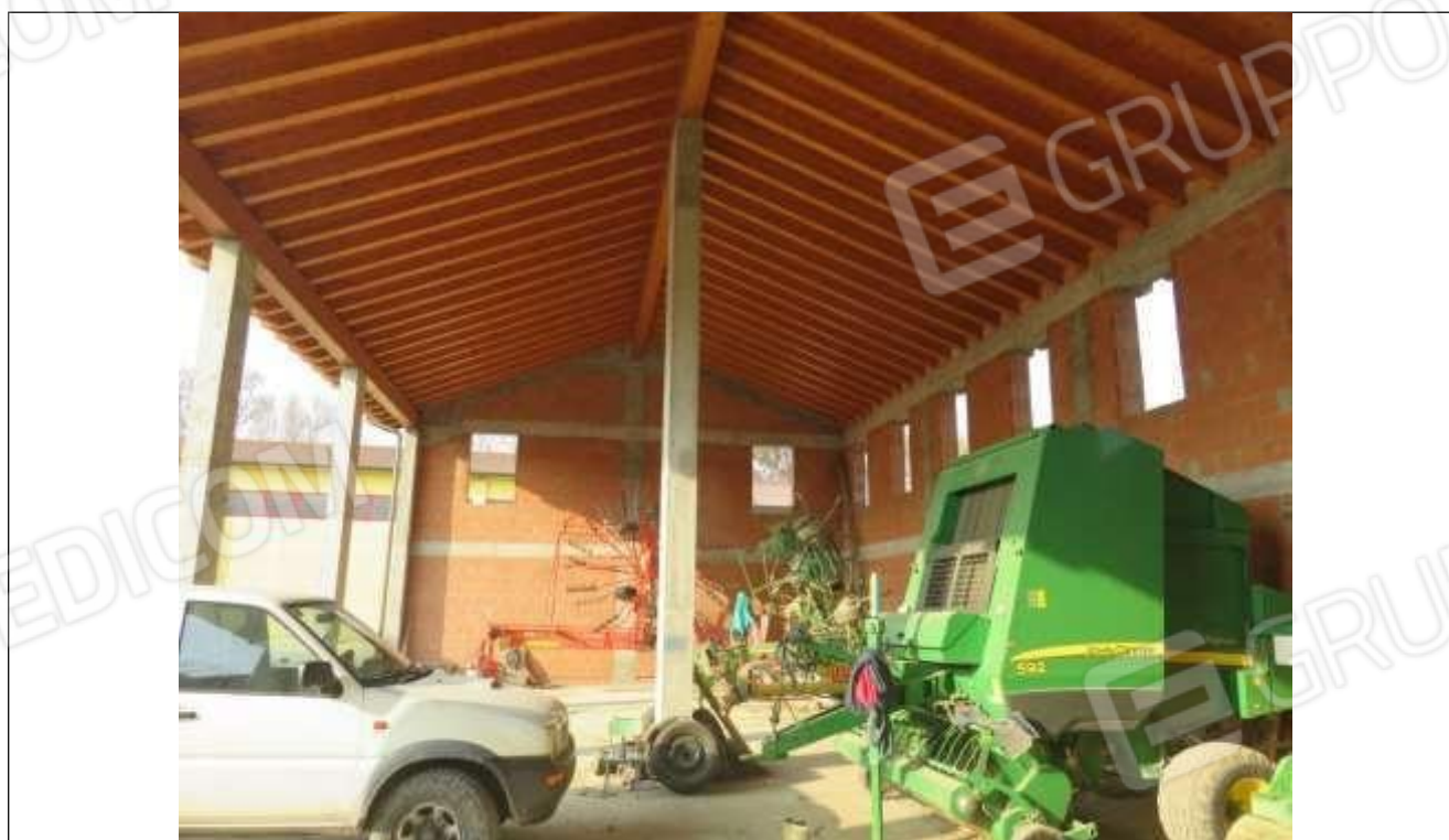
44 Altra vista dell'annesso;
