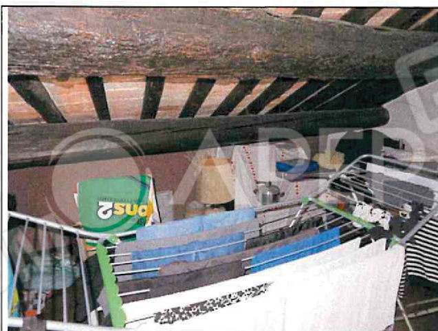
Foto n°44: Altra vista soppalco verso ovest
