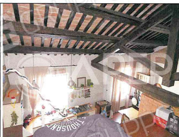
Foto n°45: Vista soppalco verso est -soggiorno cucina
