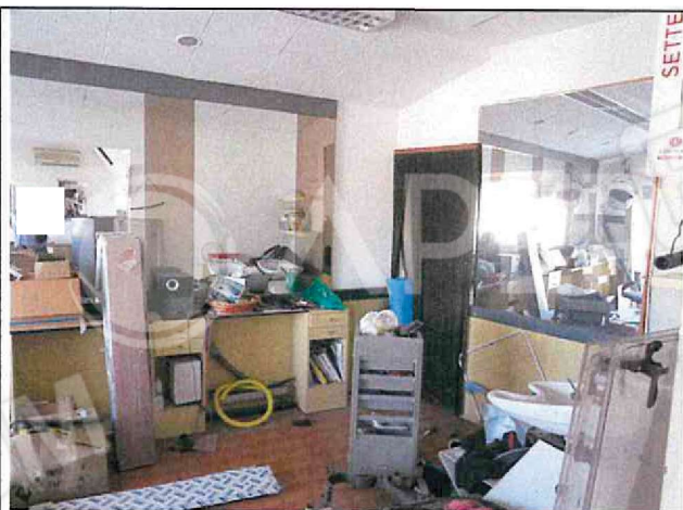
Foto n°62: Vano di lavoro a sud
