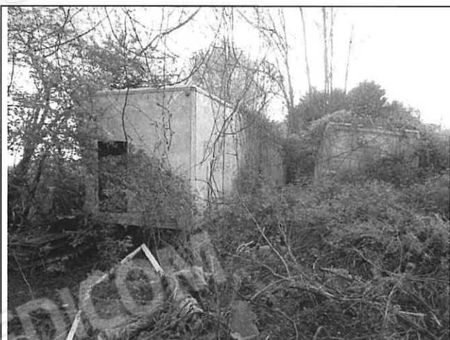
Foto n°56: Detriti e rottami ovunque
