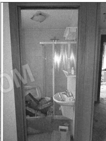
Foto n°14: Bagno al P.T.
