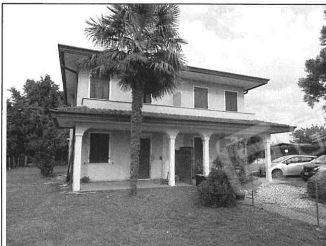
Foto n°6: Prospetto principale sud-ovest
