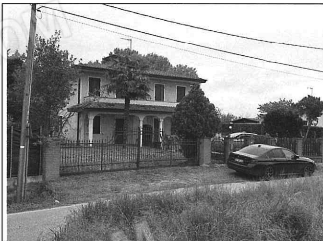
Foto n°4: Facciata principale dell'unità in esecuzione
