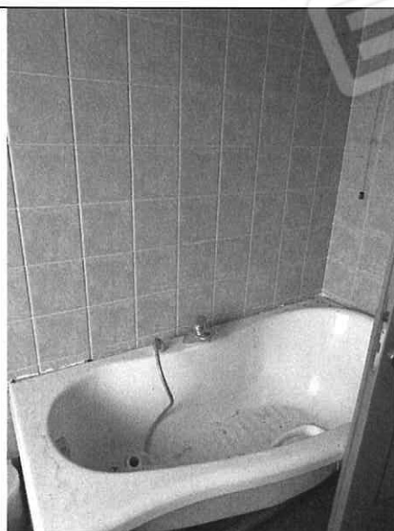
Foto n°29: Altra vista bagno
