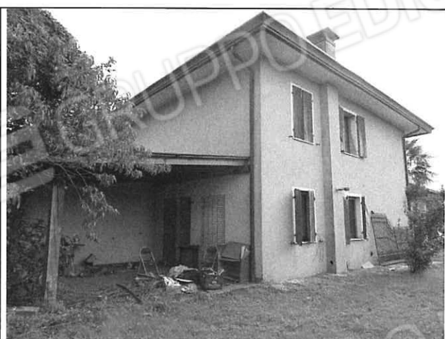
Foto n°9: Prospetto nord ovest
