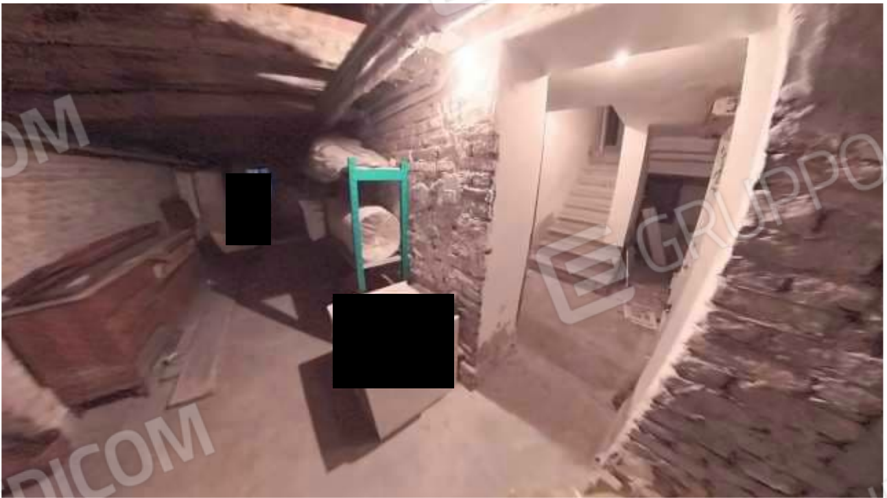
Figura 61 CANTINE AL PIANO SEMINTERRATO
