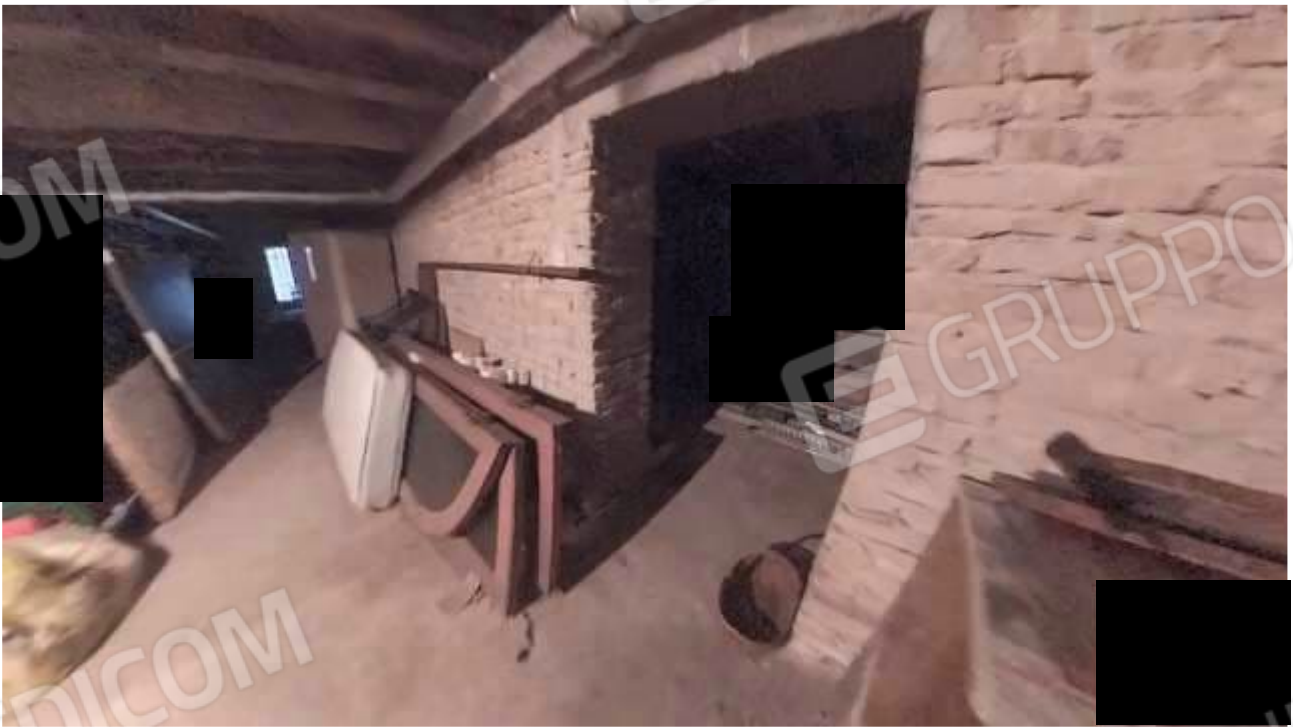
Figura 59 CANTINE AL PIANO SEMINTERRATO
