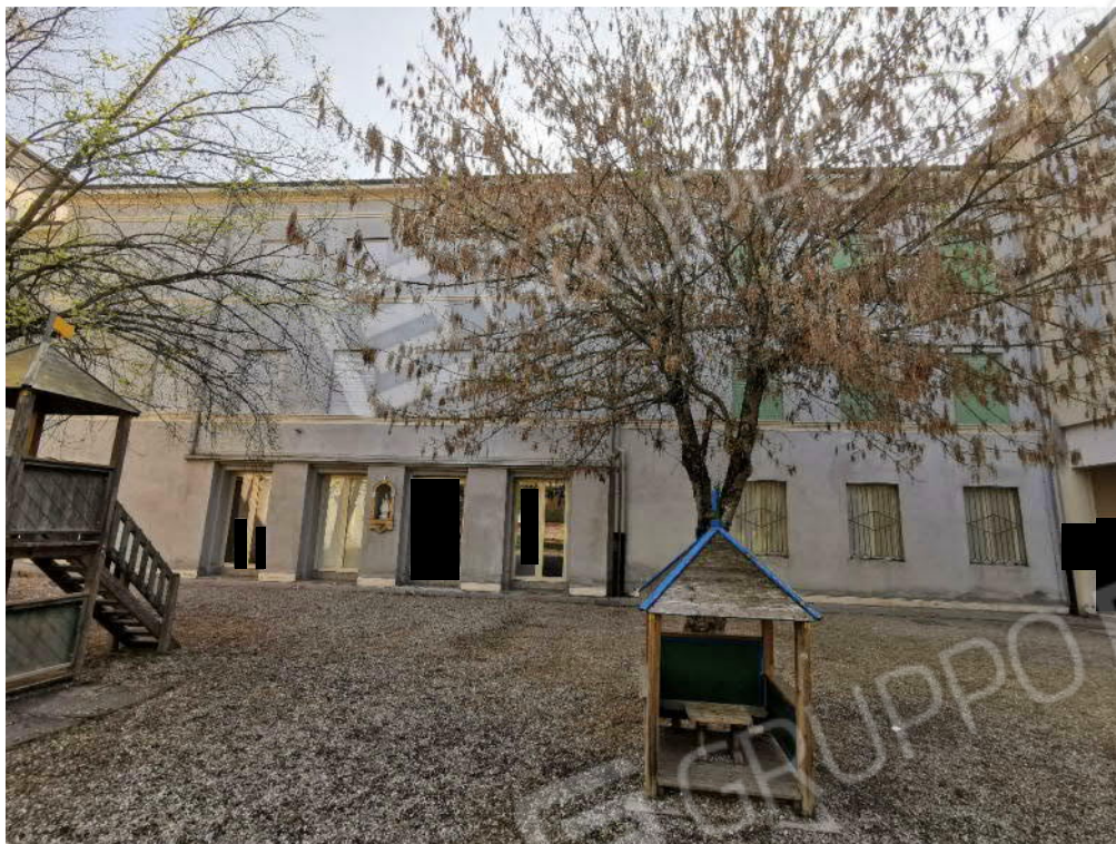
7 – particolare cortile interno
