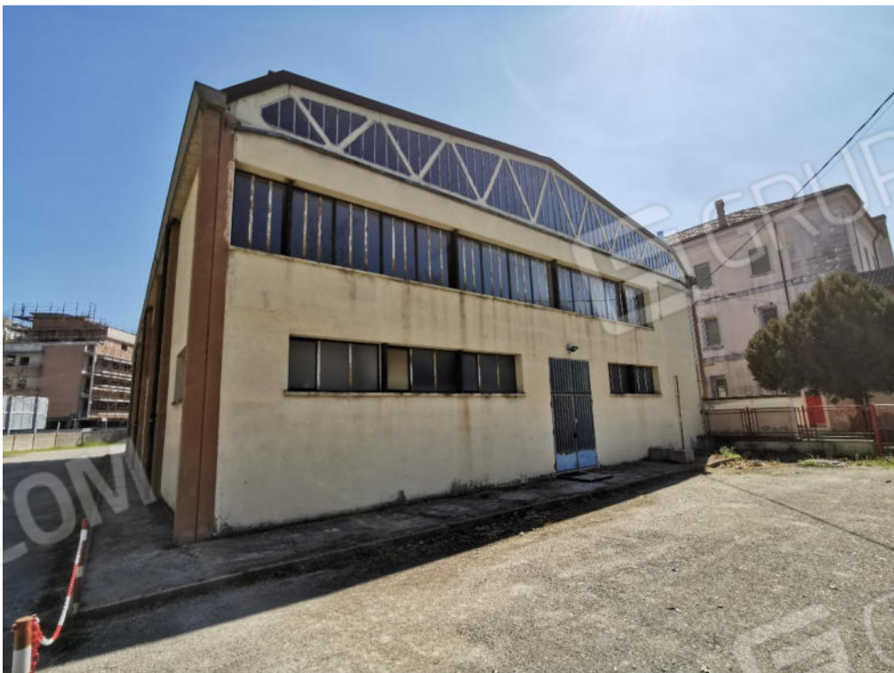
24 – particolare prospetto nord ovest - palestra fabbricato "E"
