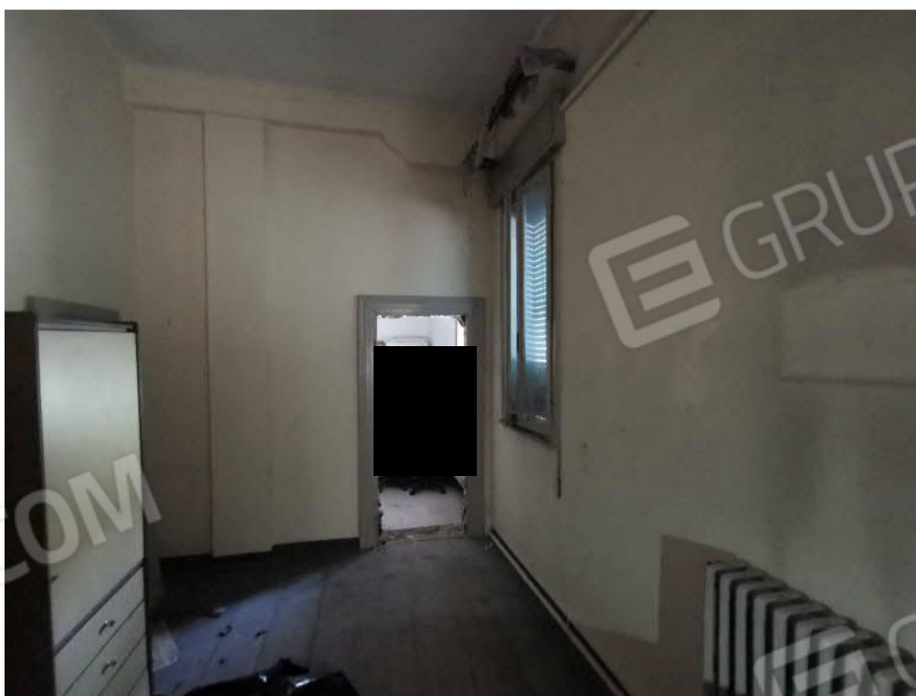
22 – particolare interno piano primo fabbricato "A"
