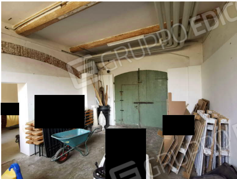
21 – particolare interno piano terra fabbricato "A"
