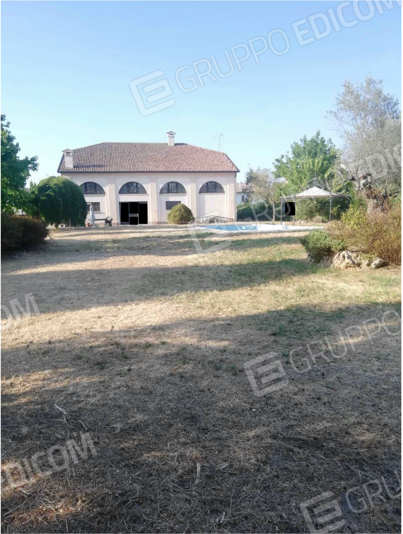
Vista immobile da sud
