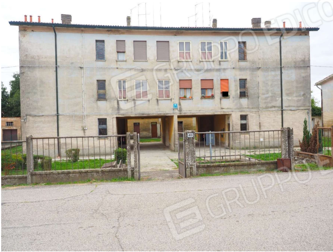
Figura 2 ESTERNO LATO NORD (FRONTE STRADA)
