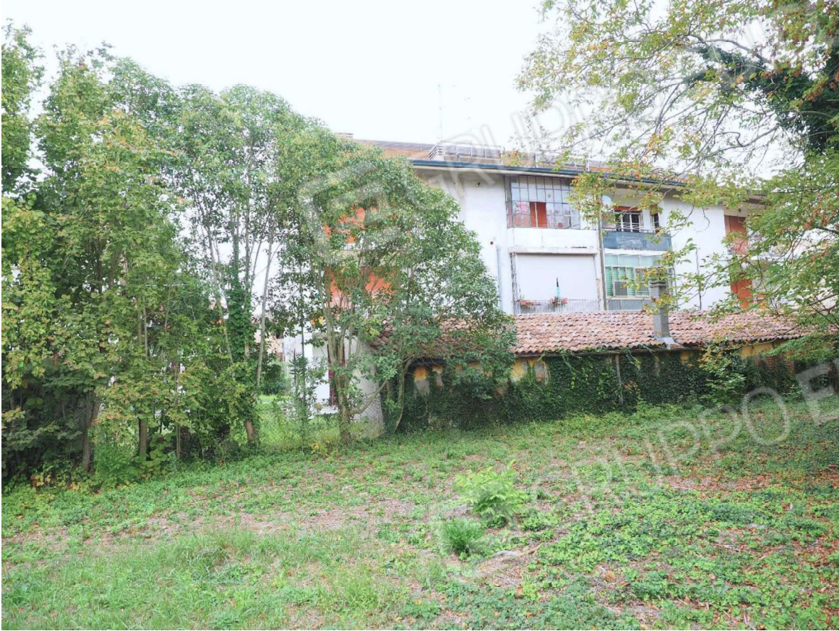
Figura 4 VEDUTA DA SUD
