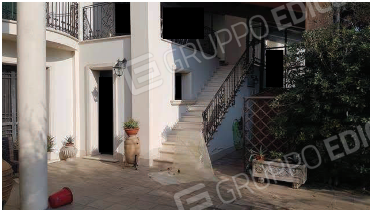
FOTO N. 07 - PARTICOLARE FRONTE EST
