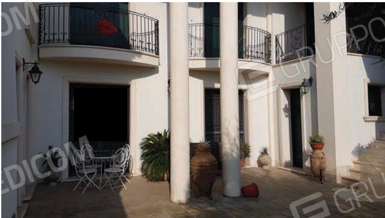
FOTO N. 06 - PARTICOLARE FRONTE EST
