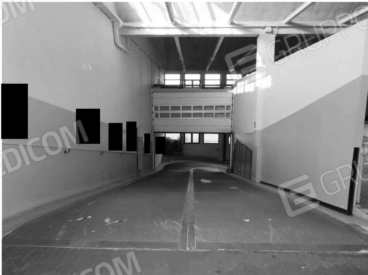
RAMPA AUTO PER L'ACCESSO ALL'OFFICINA
