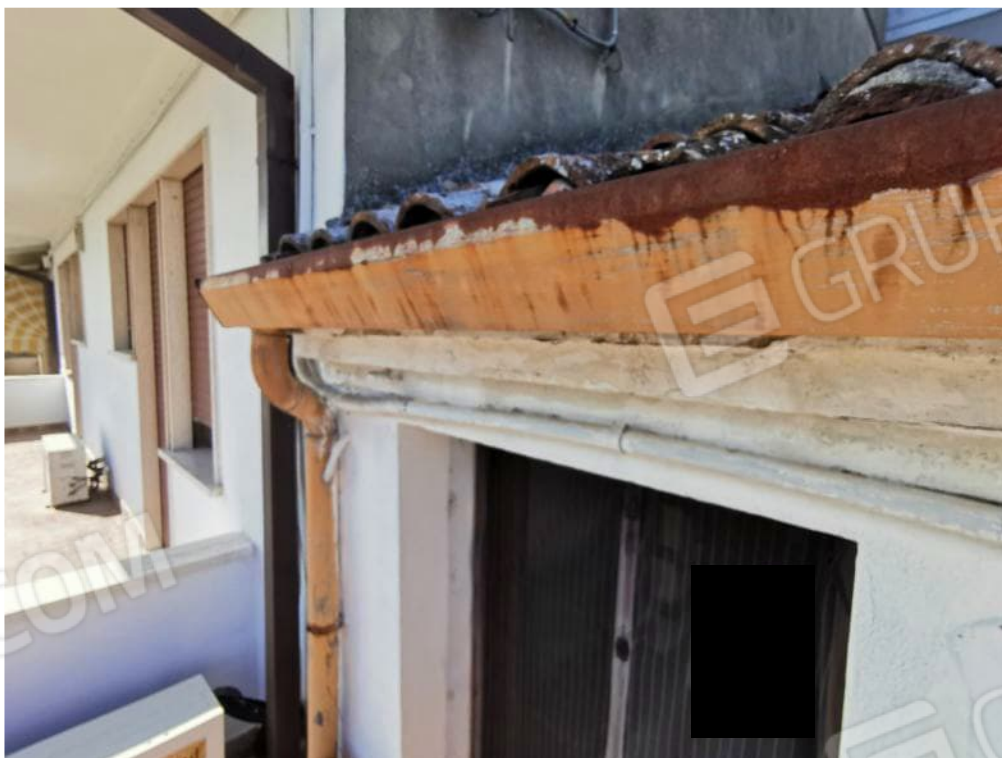
12 – PARTICOLARE TETTO E FABBRICATO ADERENTE
