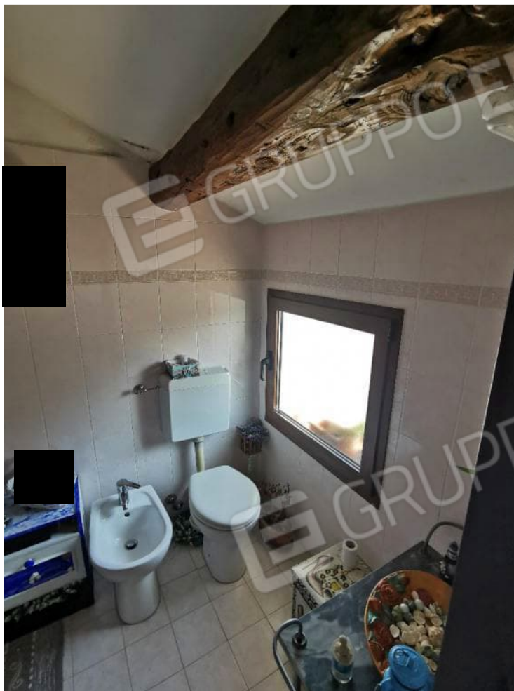
9 – PARTICOLARE INTERNO PIANO PRIMO
