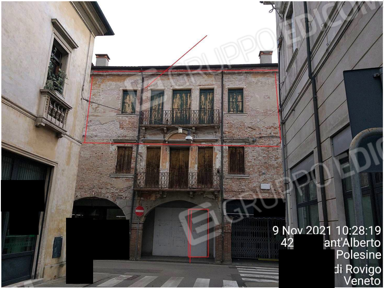
Foto vista ovest immobile pignorato parte superiore lotto 1; parte inferiore lotto 2.
