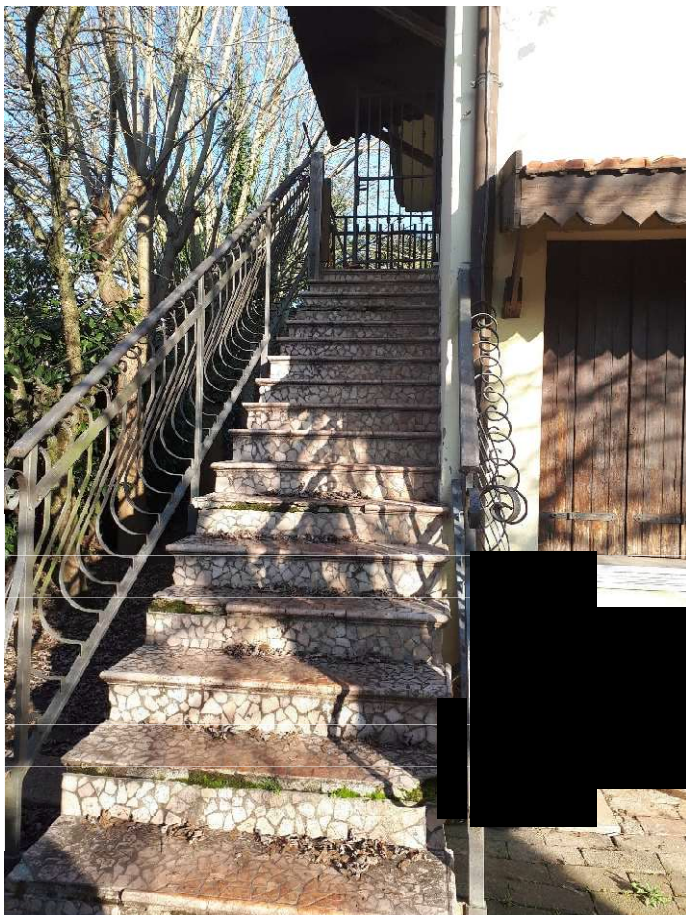
scale per raggiungere il piano primo
