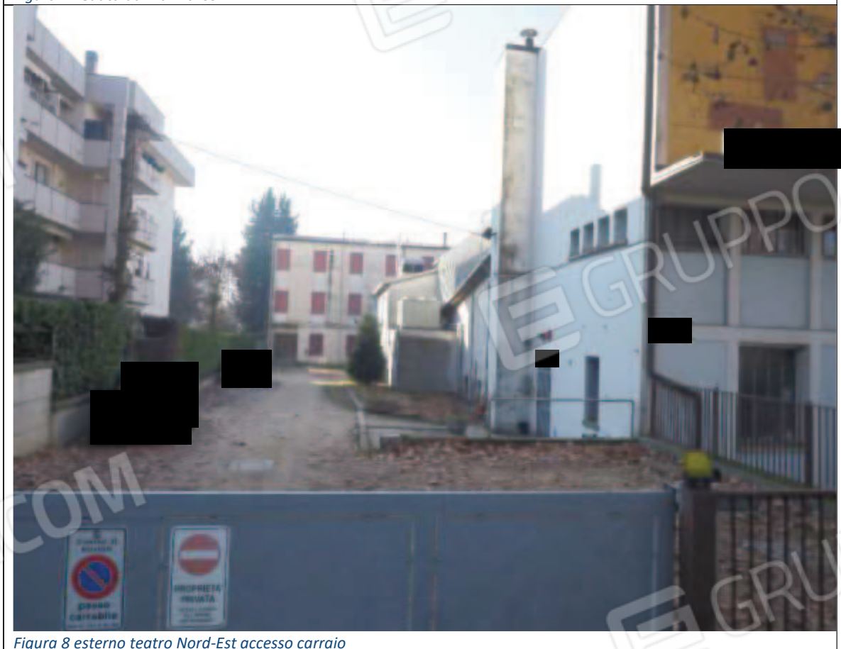
Figura 8 esterno teatro Nord-Est accesso carraio
