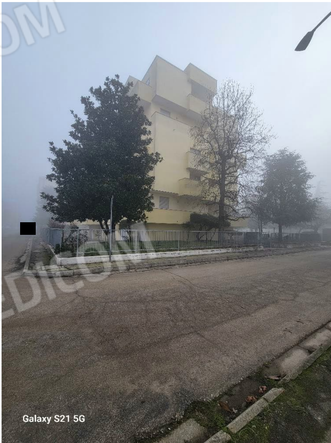
Figura 3 Esterno Lato Ovest
