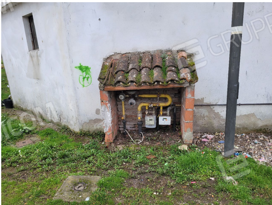
Figura 9 Particolare contatori Metano
