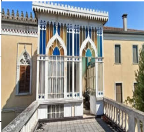
Vista della veranda
