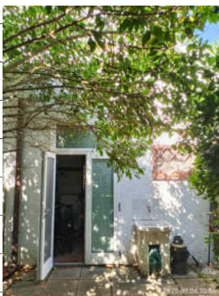
vista prospetto sul retro
