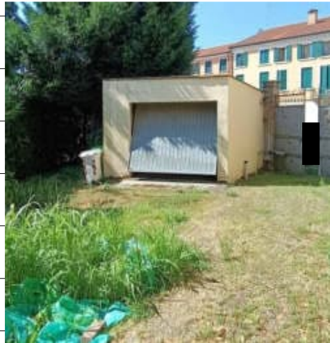
vista garage sud-ovest
