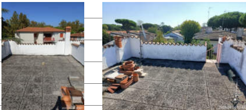
Viste della terrazza di copertura
